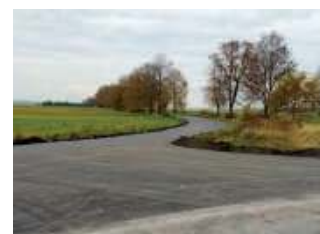
Wyremontowano 960 metrów drogi
