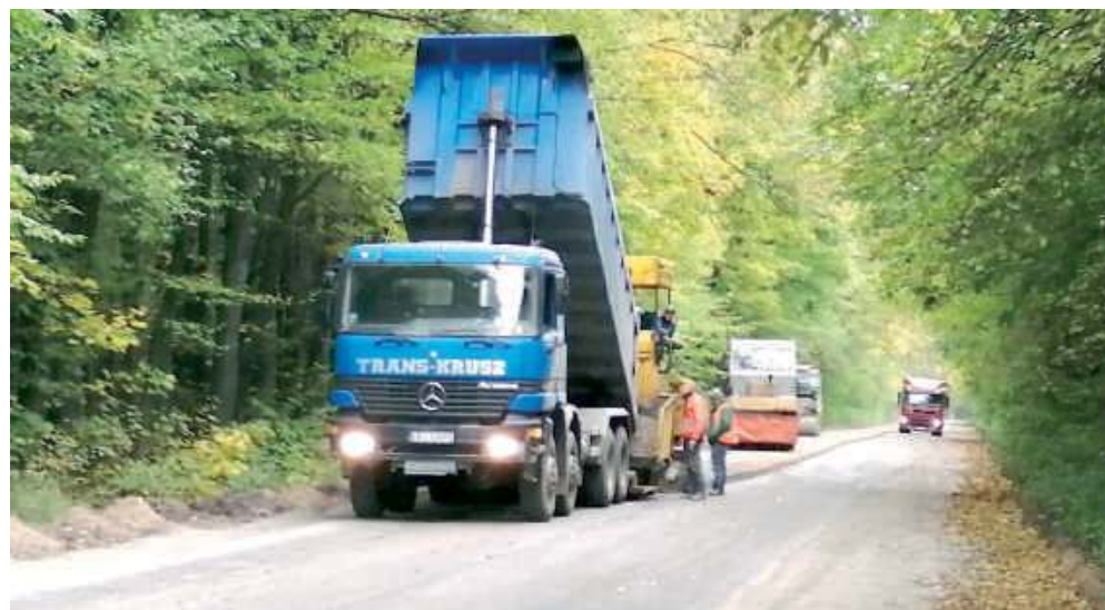
Prace wykonuje Przedsiębiorstwo Robót Drogowo-Mostowych z Parczewa za 7 mln 211 tys. zł. Budowa drogi ma się zakończyć do 15 lutego 2021 r.
