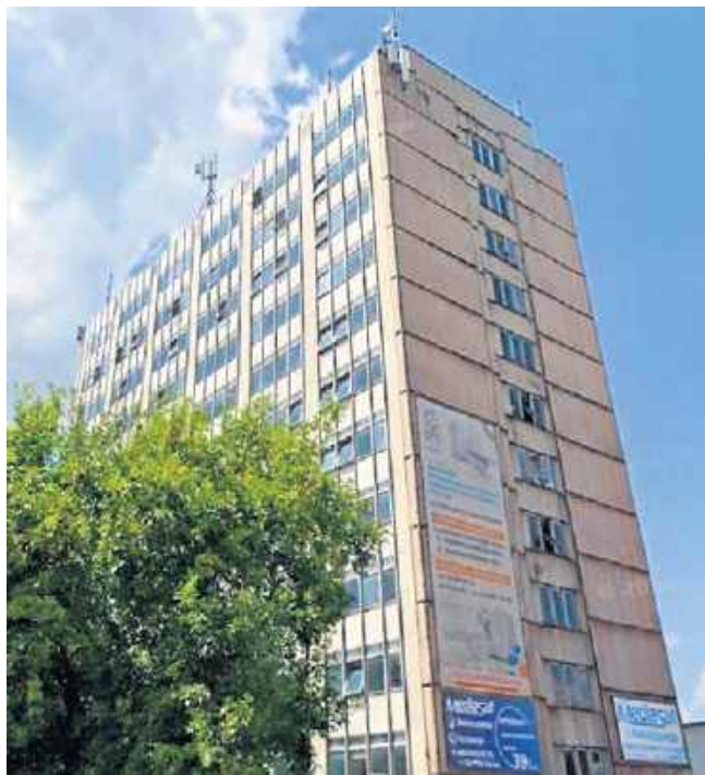
Biurowiec „Lipsk” znajduje się przy ul. Teatralnej 9. To budynek z końca lat 70. XX w.
