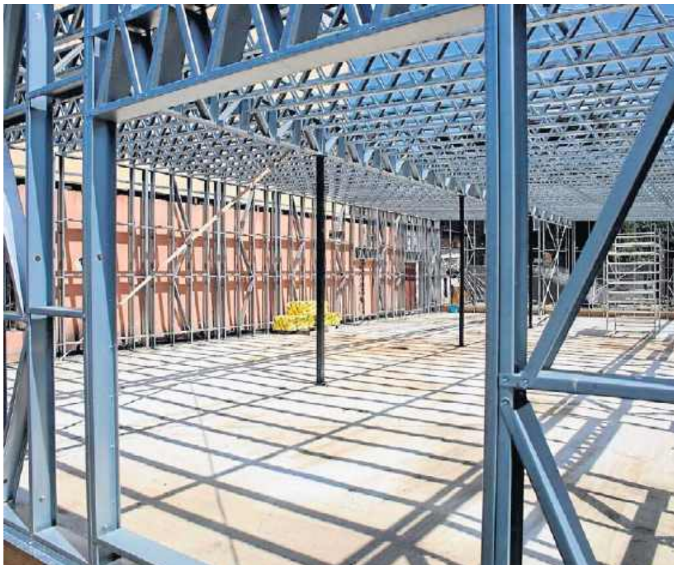
Nowa salka warsztatowa powstaje w katowickiej dzielnicy Zawodzie
