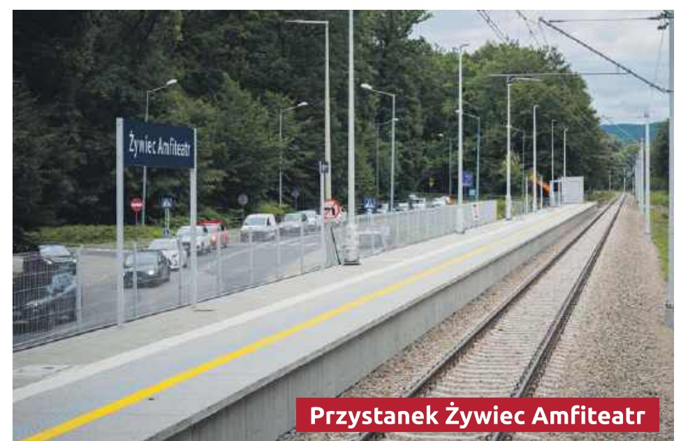
Most i tunel w Lachowicach
