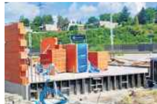
Na budowie centrum przesiadkowego trwa wznoszenie ścian oraz wykonywanie konstrukcji żelbetowych
