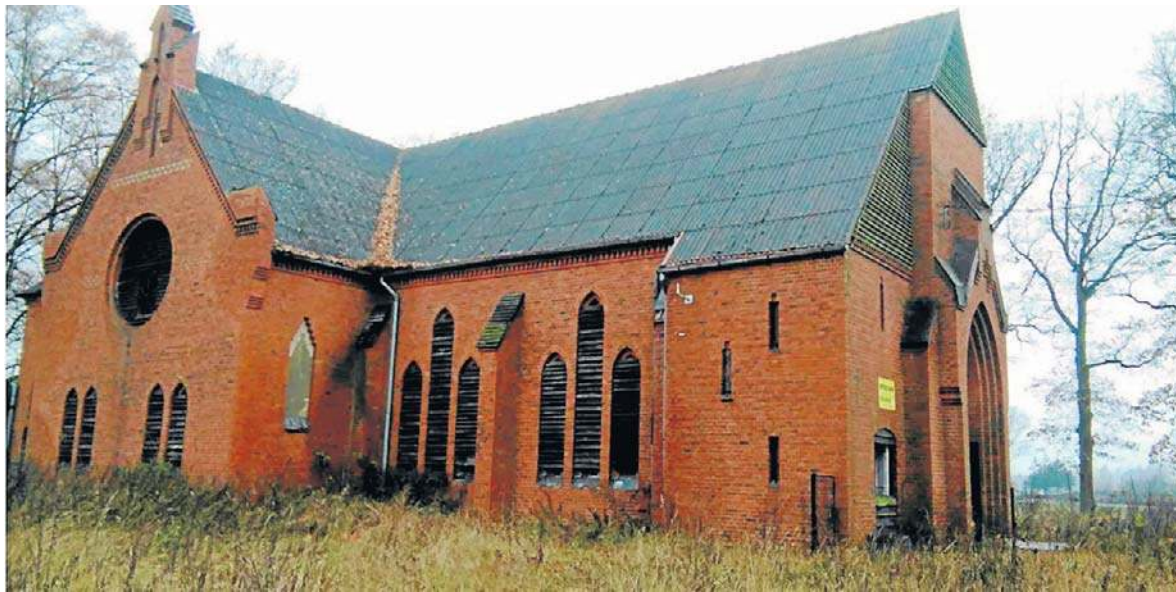
W 1889 r. urządzono w Wielkądzu nową parafię ewangelicką: poświęcono fundamenty, wzniesiono kościół. Po wojnie opuszczona świątynia wykorzystywana była m.in. jako magazyn zbożowy
