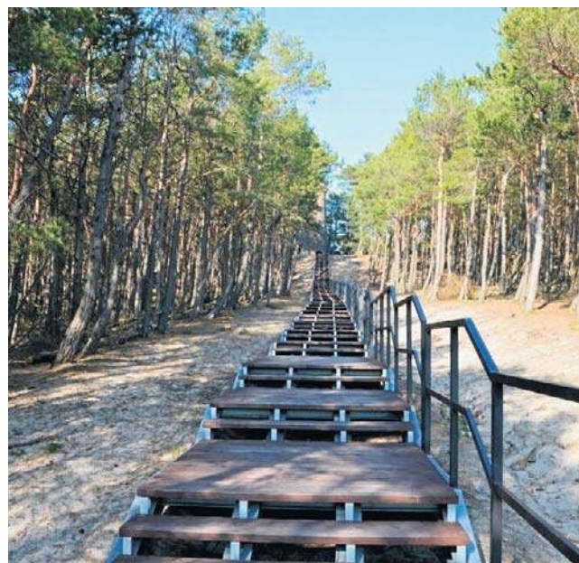
Schody na latarnię
