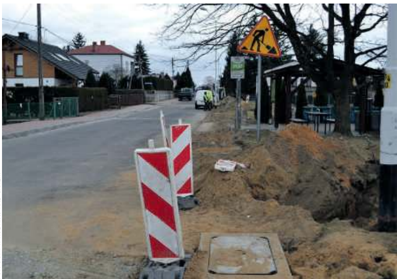
Prace przy remontach na rudnickich drogach już trwają
