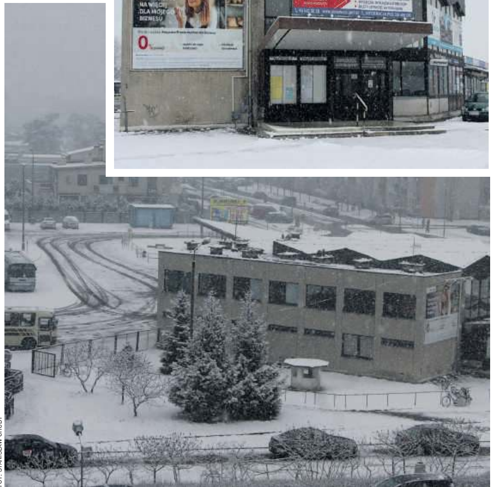
Dworcowi PKS w Stalowej Woli stuknie w tym roku 48 lat. 10 ostatnich lat to z kolei daremne oczekiwanie na budowę nowego dworca
