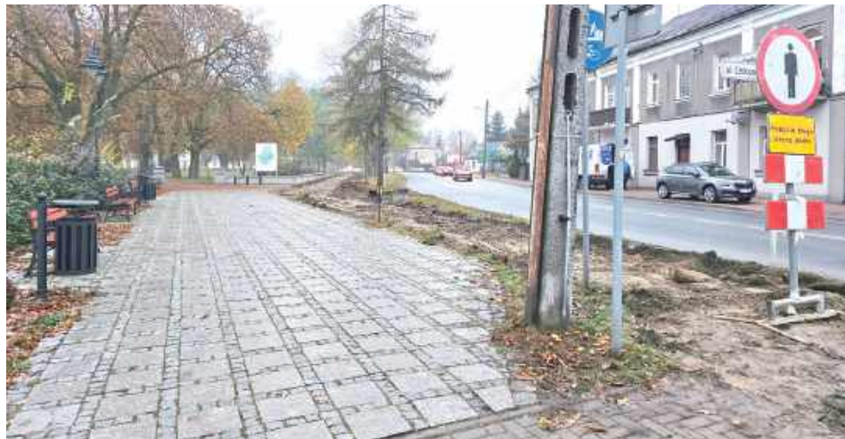
Prace trwają od początku ubiegłego tygodnia
