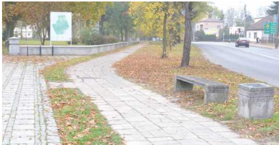
W połowie grudnia mieszkańcy Międzyrzecza będą mogli przejść nową nawierzchnią
