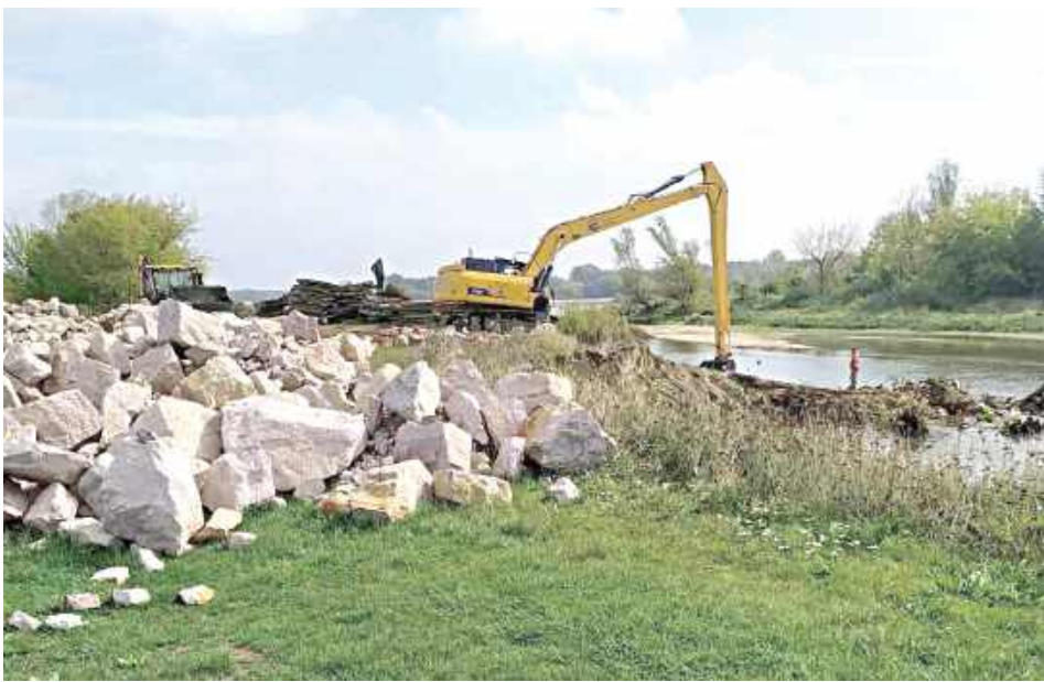
Problem w rejonie 424. kilometra Wisły był wskazywany jako jeden z pilnych do rozwiązania podczas ubiegłorocznego przeglądu zabezpieczeń przeciwpowodziowych
