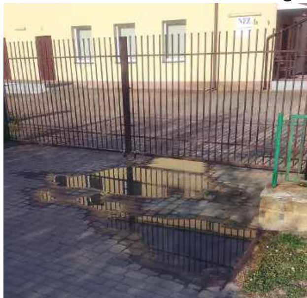
Taki widok to sygnał, że znów źle się dzieje. Awaria na ul. Strażackiej w Machnowie Nowym (kwiecień 2026).
