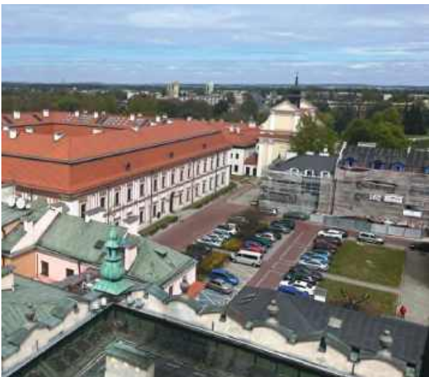
Projekt przewiduje między innymi uporządkowanie zasad parkowania w Strefie A. Wyznaczone mają zostać konkretne miejsca dla mieszkańców, osób z niepełnosprawnościami, służb i innych uprawnionych użytkowników. Fot. UM Zamość
