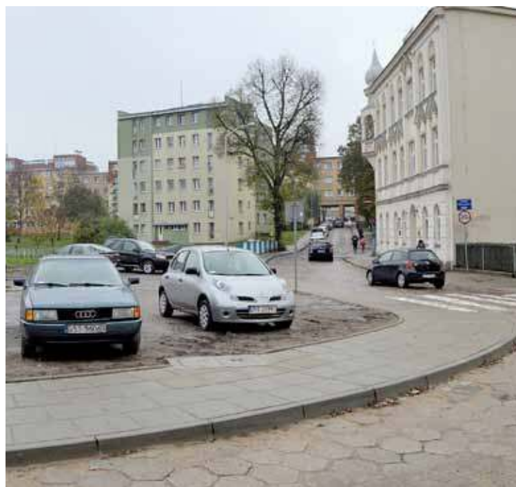
Zakończyła się budowa chodnika w ciągu ul. Włosienniczej i Kuśnierzy
