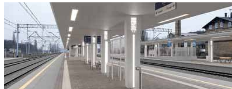
W ramach inwestycji PKP perony zostaną przebudowane oraz dworzec kolejowy zostanie połączony z ZCP
