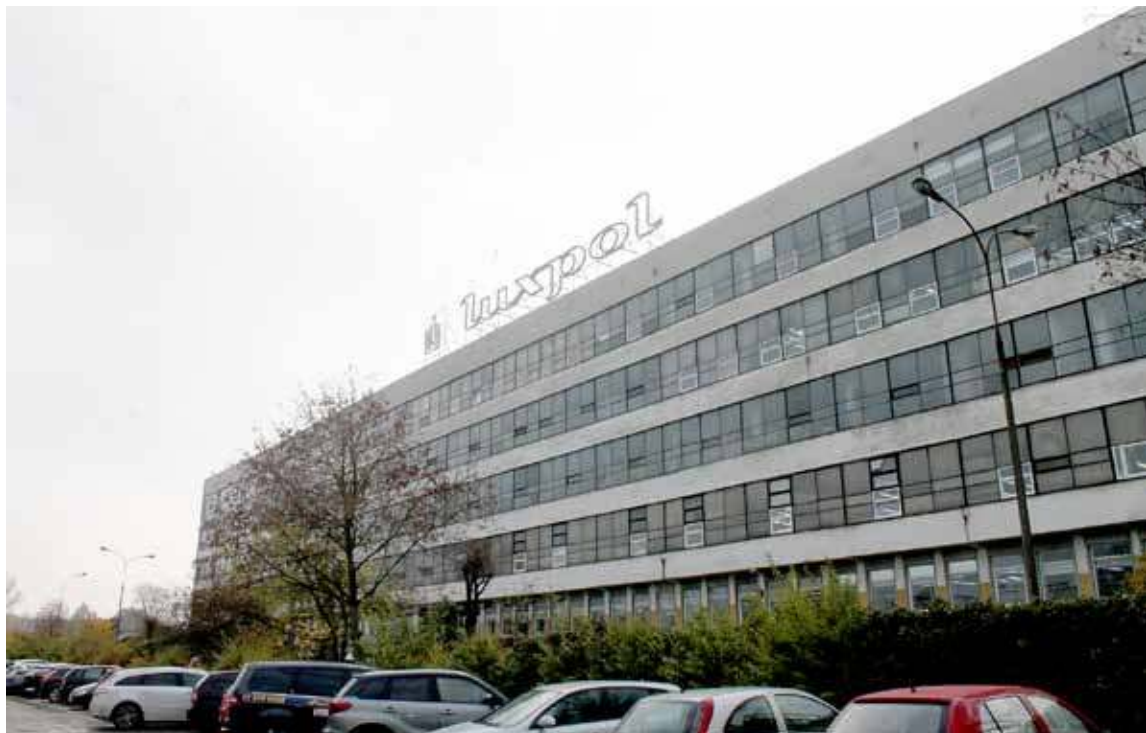
Dokładnie 51 lat temu, 8 listopada 1968 r., dokonano wmurowania aktu erekcyjnego pod budowę Luxpolu
