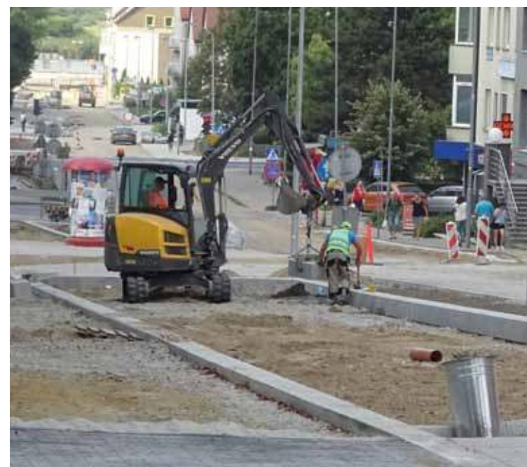
Prace poniżej dworca
