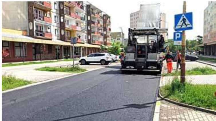
Po sfrezowaniu starej nawierzchni rozpoczęto układanie warstwy wyrównawczej
