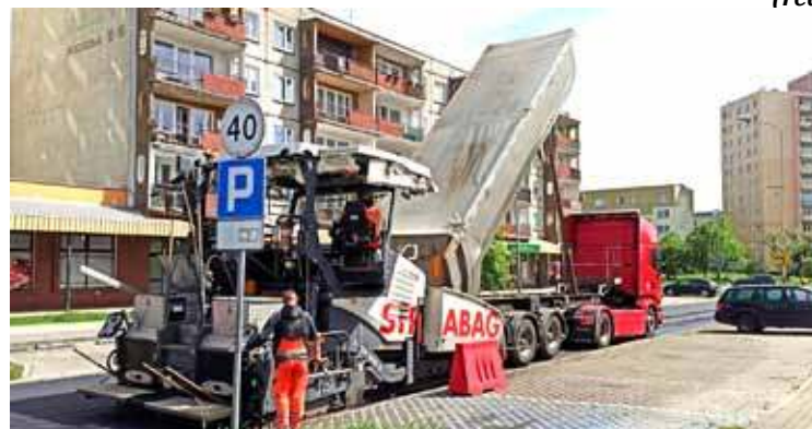
Wykonawca rozpoczął gruntowny remont
