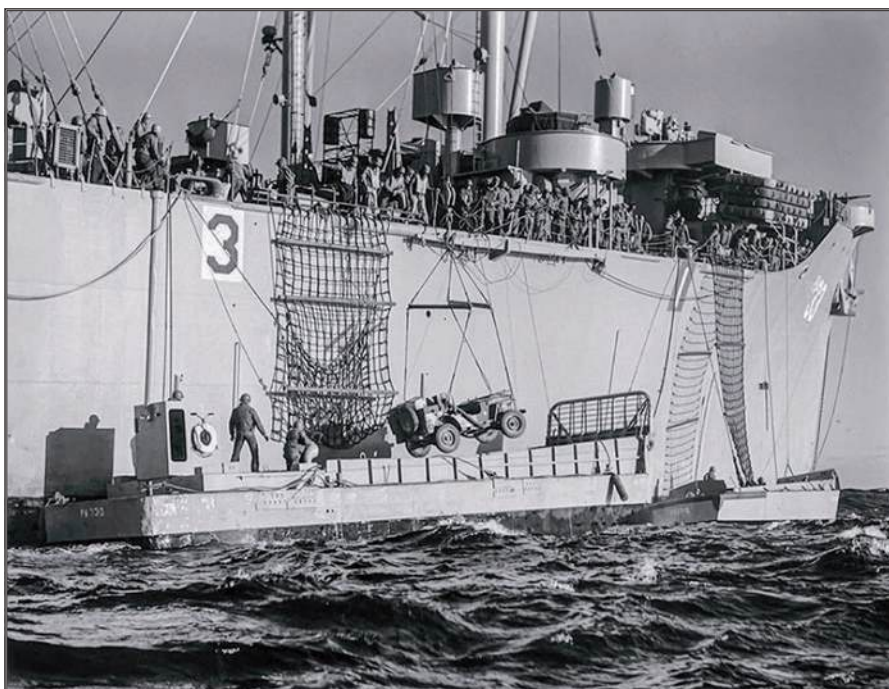
Rozładunek okrętu transportowego: przy użyciu pokładowych żurawi na barkę opuszczany jest samochód osobowo-terenowy.
