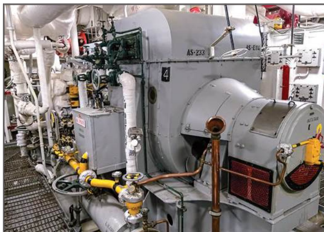
Jeden z turboagregatów prądu zmiennego pancernika USS Iowa (BB-61). Wczesne przejście US Navy na systemy zasilania AC zapewniło amerykańskiemu okrętowi znaczną przewagę w zakresie produkcji i dystrybucji energii elektrycznej, niezbędnej dla nowoczesnych systemów bojowych i okrętowych urządzeń pomocniczych.
