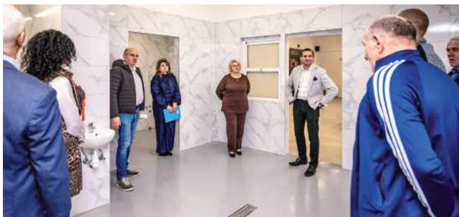
W ramach realizacji zadania przeprowadzono kompleksową przebudowę kuchni, której celem było zwiększenie przestrzeni i dostosowanie jej do obowiązujących norm sanitarno-epidemiologicznych
