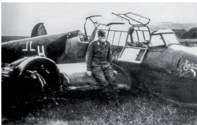
▲ Samolot Messerschmitt Bf 110C (L1+HH) z 1.(Z)/LG 1, który 15 września 1939 roku uległ awarii silnika podczas lotu transferowego i musiał awaryjnie lądować. Dobry przykład straty, która nie została podana w listach głównego kwatermistrza Luftwaffe. Rzecz niewytłumaczalna, biorąc pod uwagę fakt, że załoga odniosła drobne obrażenia podczas przymusowego lądowania, a samolot został spisany ze stanu jednostki – arch. Robert Szołtyk.
