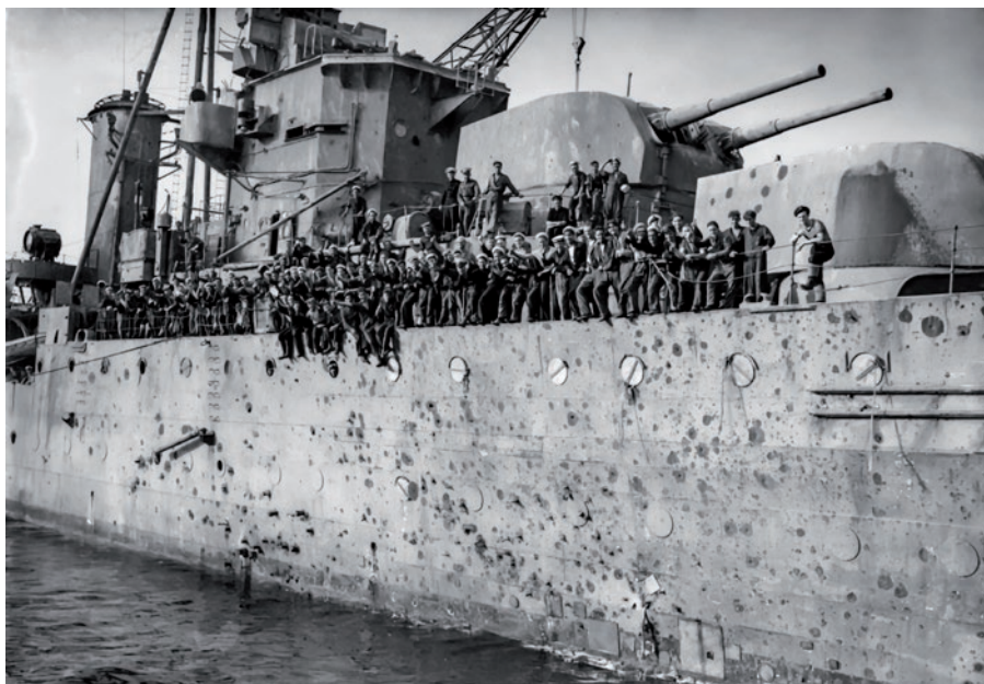
▲ Krążownik HMS Penelope w Gibraltarze w 1942 roku, widoczne uszkodzenia po bliskich eksplozjach bomb.
