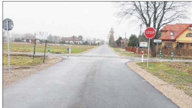
W zeszłym roku została wybudowana ul. Nowa w Drelowie, to droga gminna wykonana od podstaw
