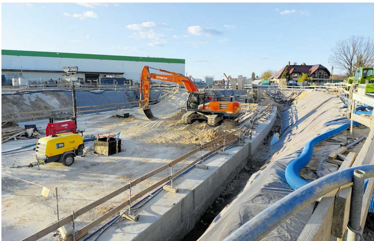
• Budowa tunelu łączącego bazę drugiej linii metra Mory z pierwszą stacją Karolin pod skrzyżowaniem ul. Połczyńskiej i Sochaczewskiej FOT. JAROSŁAW OSOWSKI
