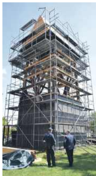
Remont dzwonnicy przy kościele w Strzeszowie
