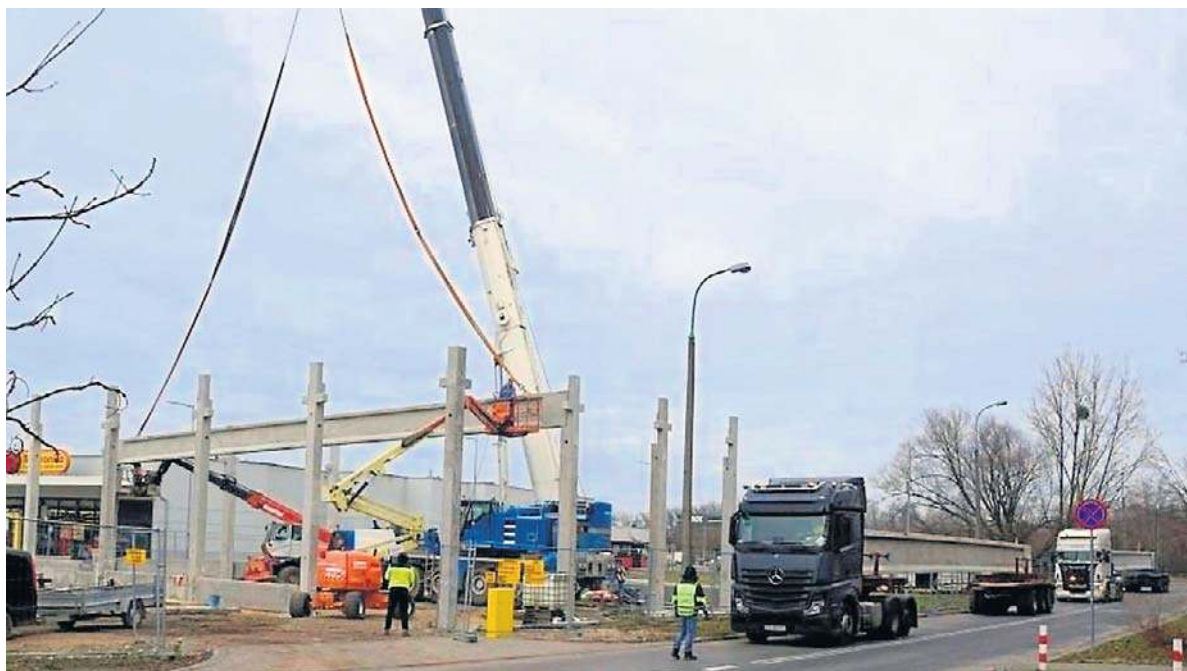
Budowa nowej galerii handlowej w Radomiu. W poniedziałek montowano dźwigary dachu budynku.
