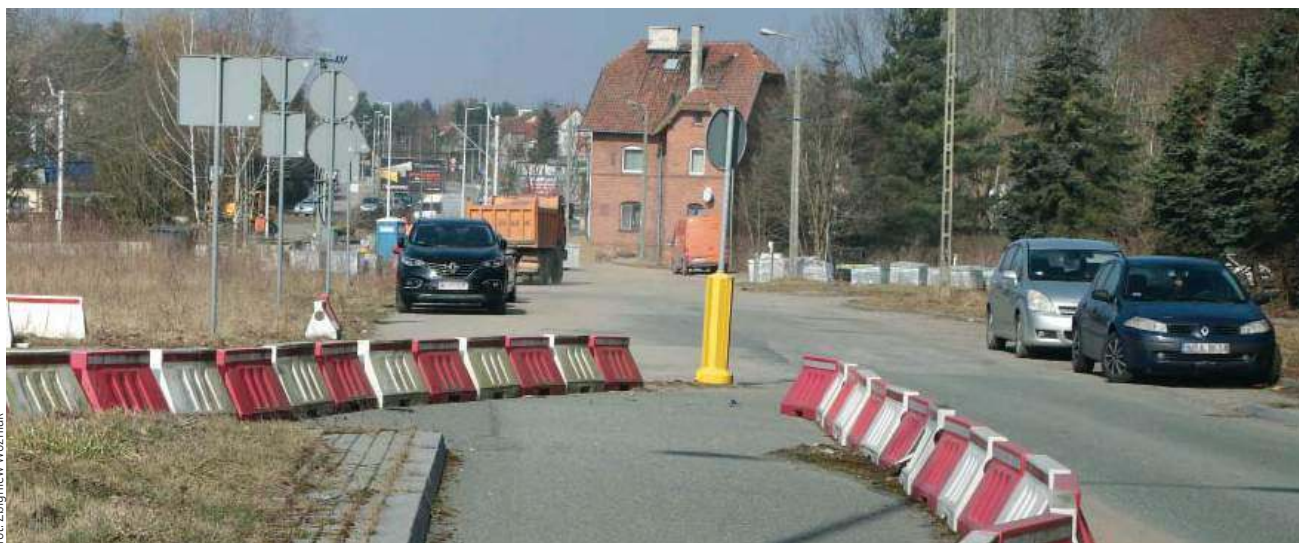
Tędy ma przebiegać ul. Nowobałtycka. Ten dom zostanie zburzony
