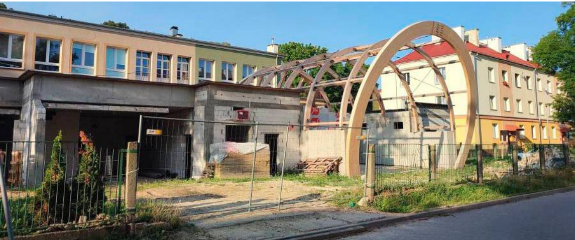
Najważniejsze, by przed zimą zdążyć z postawieniem dachu, który zabezpieczy powstałą już budowlę przedniszczeniem
