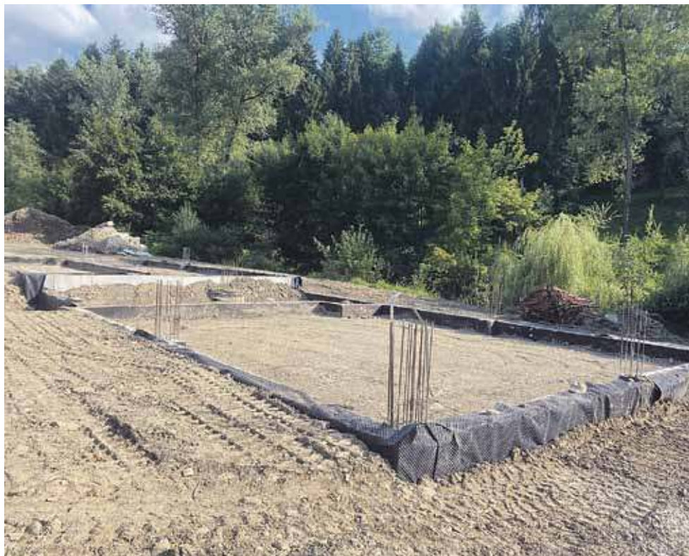
Fundamenty nowej remizy w Ponicach.
