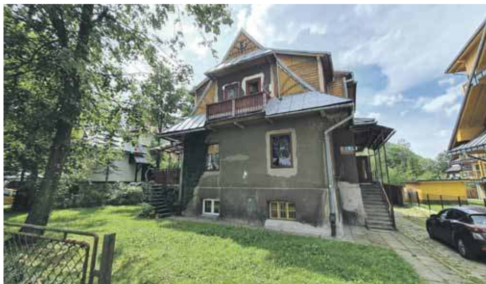
Mieszkańcy domu przy ul. Modrzejewskiej chcą, aby piwnice w ich budynku nie były zamieszkałe.
