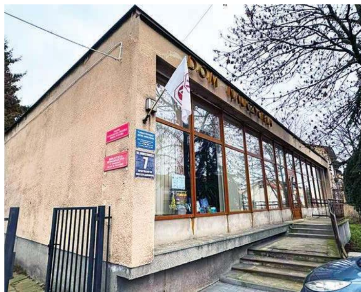
Ratusz chce wyremontować budynek tzw. Domu Nauczyciela
