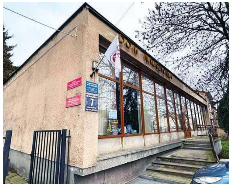
Ratusz chce wyremontować budynek tzw. Domu Nauczyciela
