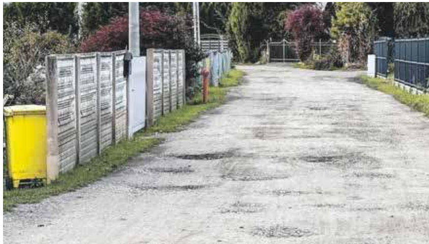
Kostka brukowa zastąpi grunt
