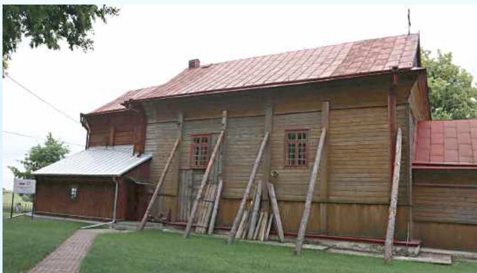
- Fatalny stan zachowania podwalin kościoła mógł doprowadzić do katastrofy budowlanej - mówi Lubelski Wojewódzki Konserwator Zabytków
