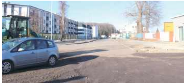
Litościwa zima pozwoliła na wykonanie już wielu prac przy zbiegu białskiej al. Jana Pawła II i ul. Kościuszki
