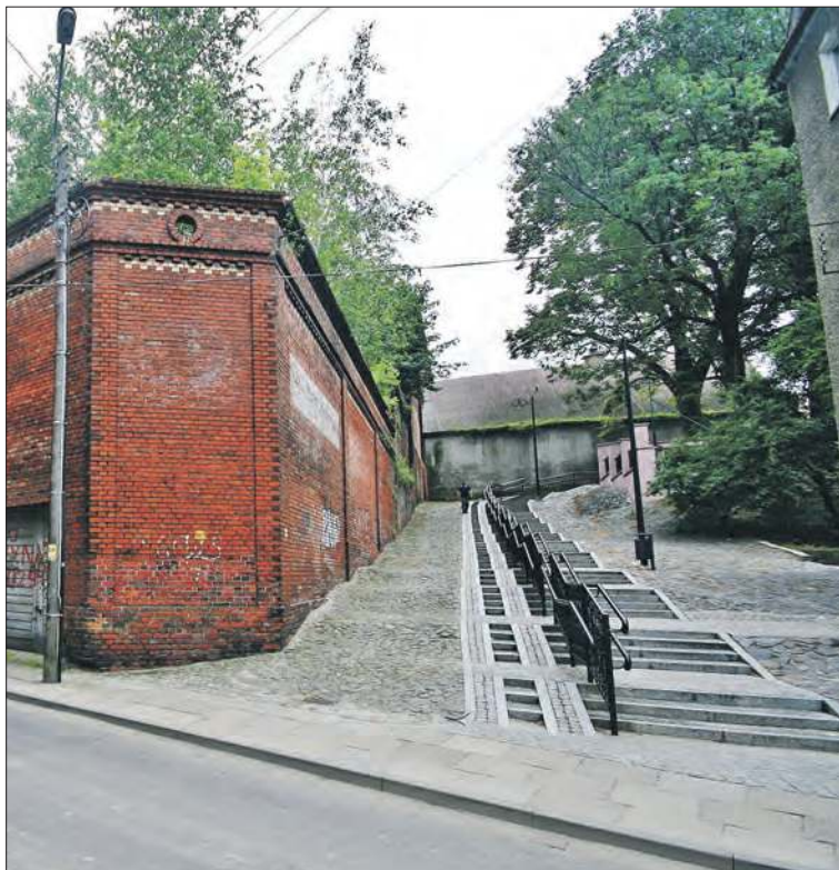
Ulice Chrobrego i Stroma w Prudniku
