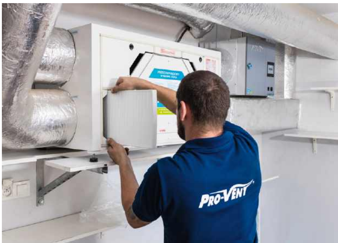
📍 Filtry należy wymieniać co 3 do 6 miesięcy. Jeśli to zaniedbamy, wzrosną opory przepływu powietrza. PRO-VENT
