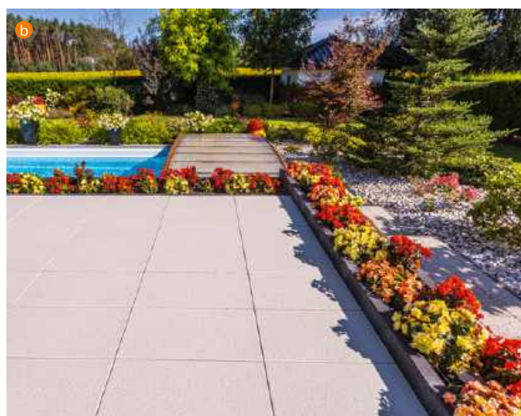
📌 Krawędzie tarasu z kostki lub płyt zabezpiecza się betonowymi palisadami lub krawężnikami (a SEMMELROCK) i obsadza roślinnością (b VESTONE).
