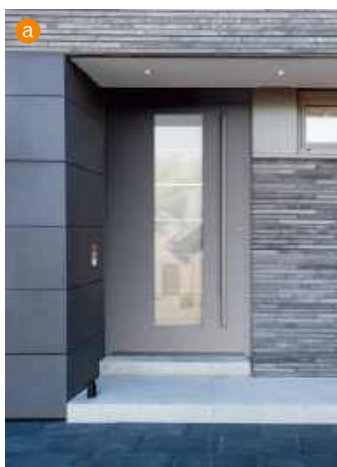
📌 Pojedyncze skrzydło drzwi wejściowych ma szerokość przynajmniej 90 cm i wysokość 200 cm (a HÖRMANN). Przeszklenia boczne mogą mieć dowolną szerokość (b STALPRODUKT-ZAMOŚĆ).
