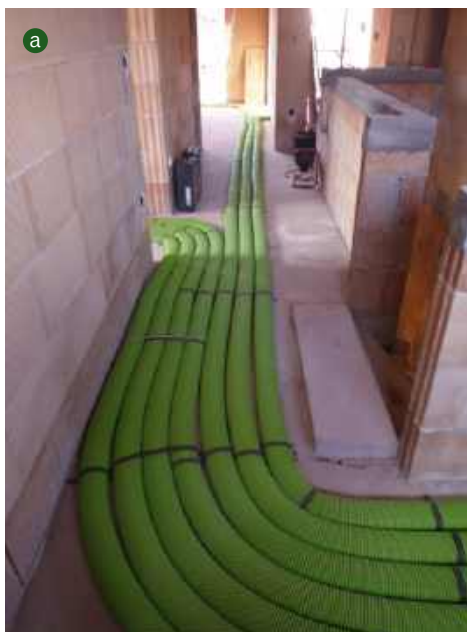
📍 Kanały wentylacyjne można ukryć pod wylewką podłogową (a WOLF), albo prowadzić nad sufitem podwieszanym (b CONCEPT AIR).
