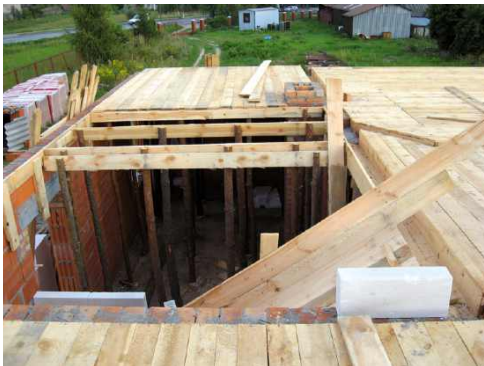
🔧 Wykonanie stropu monolitycznego jest pracochłonne – ze względu na konieczność przygotowania szalunku i zbrojenia. M. SZYMANIK
