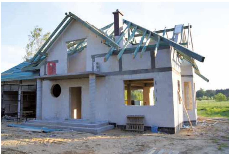
🔑 Dużą zaletą silikatów jest bardzo dobra wytrzymałość na ściskanie, izolacyjność akustyczna oraz wysoka akumulacyjność. H+H
