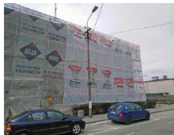
c Żeby sprostać unijnym przepisom, potrzebna będzie masowa termomodernizacja. ARBET
