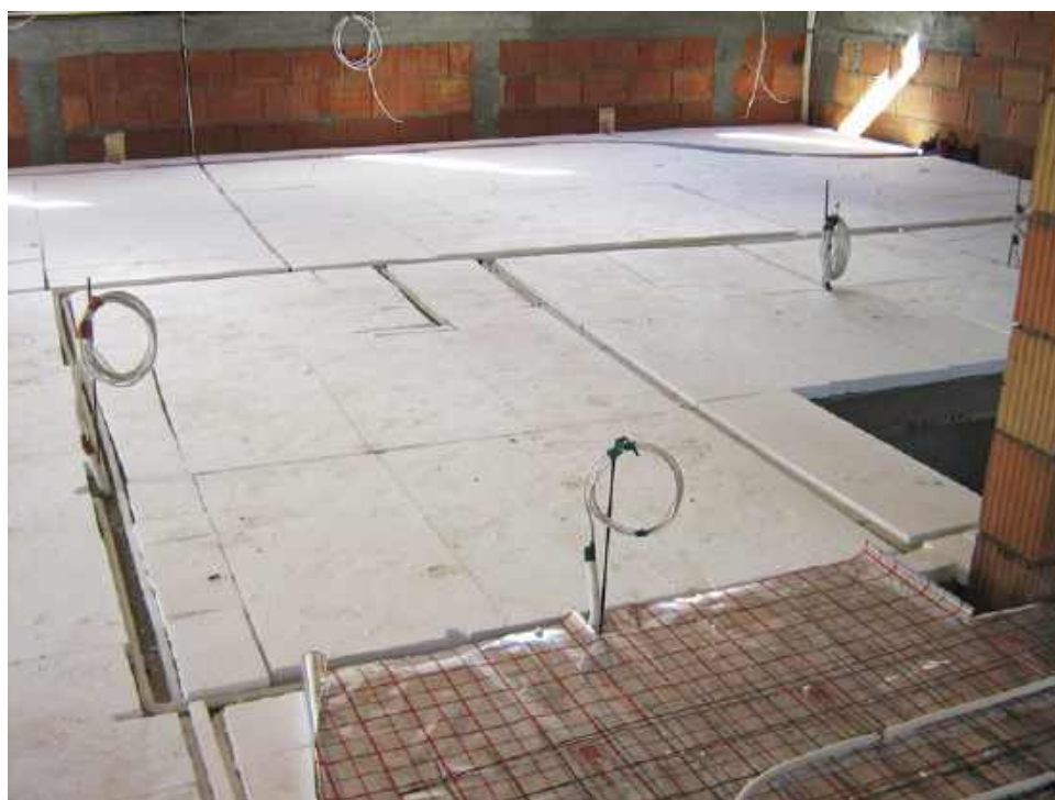
● Podłogi ocieplamy styropianem typu dach/podłoga. SWISSPOR
