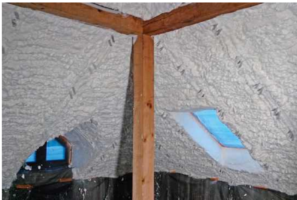
🔥 Pianka PUR bardzo skutecznie wypełnia ocieplaną przestrzeń. Dzięki temu poddasze jest wolne od mostków termicznych. CELS
