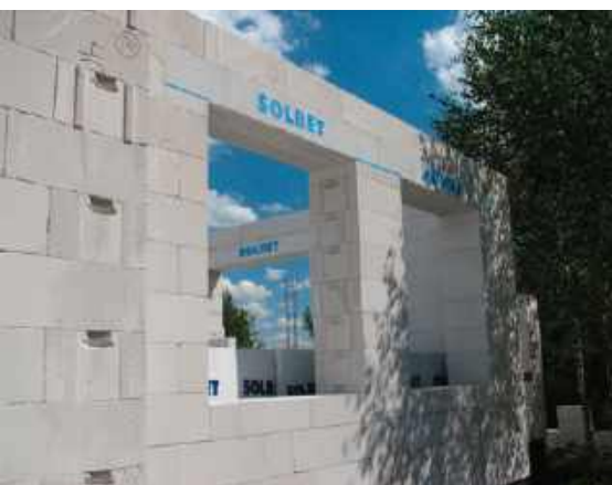
🔗 Wykorzystanie prefabrykowanych zbrojonych belek nadprożowych z ABK. T. RYBARCZYK
