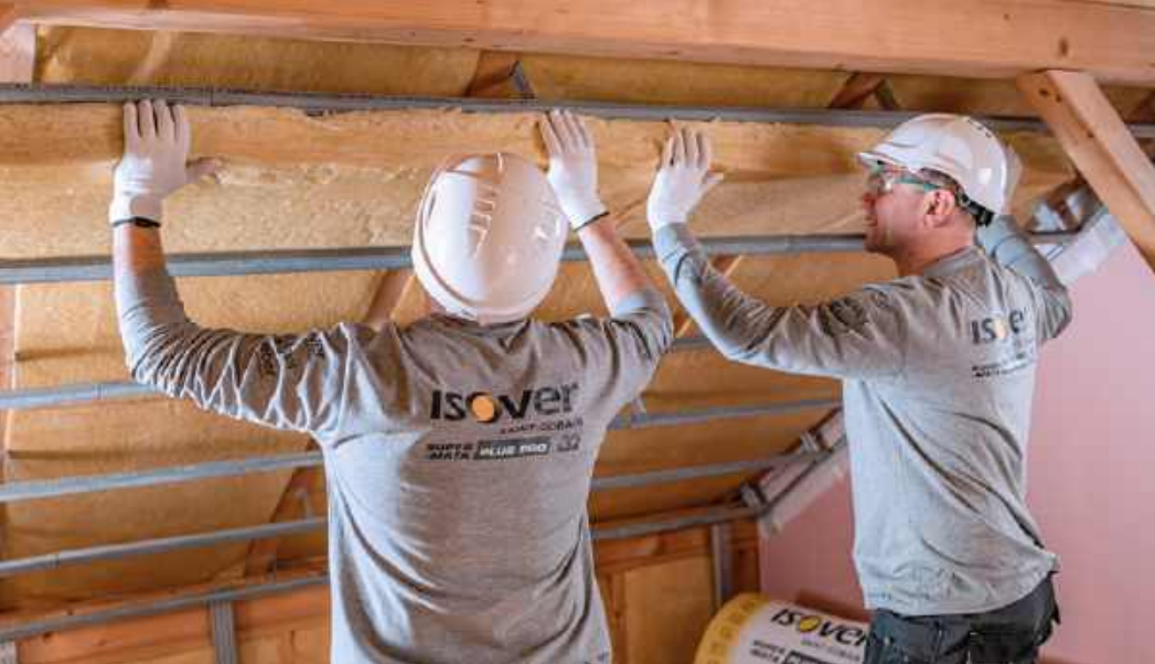
🔧 Żeby spełnić wymagania WT 2021, wełnę mineralną układa się pod połacią dachu dwuwarstwowo. ISOVER
