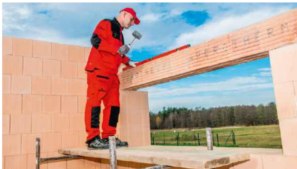
🔔 W metodzie jednowarstwowej dużym wyzwaniem jest wyeliminowanie ryzyka powstania mostków termicznych. Dlatego zaleca się stosowanie rozwiązań systemowych, takich jak prefabrykowane belki nadprożowe czy docieplone kształtki. WIENERBERGER
