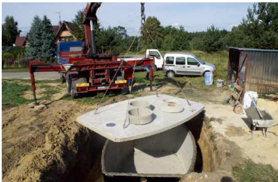
📌 Kłopoty z szambem mogą się pojawić już na etapie jego planowania. Montaż zbiornika z betonu wymaga np. użycia ciężkiego sprzętu. PROBUD
