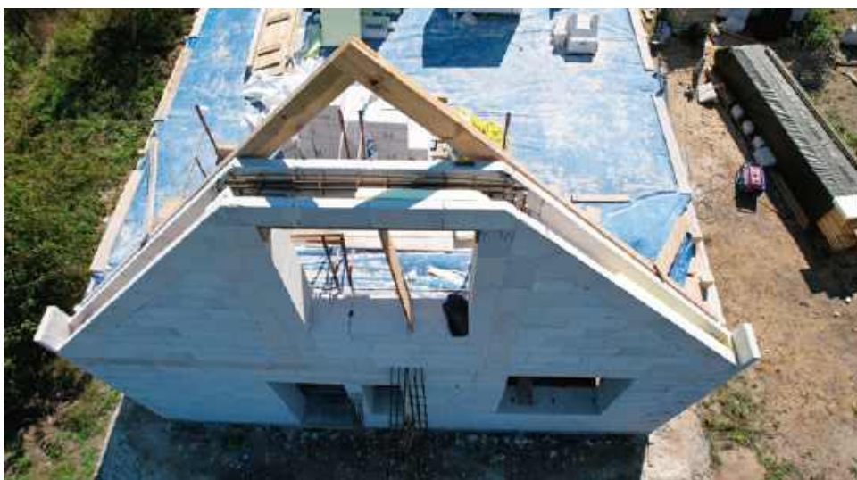
🔗 Wieniec obwodowy wykonywany w kształtkach U z dodatkowym ociepleniem. T. RYBARCZYK
