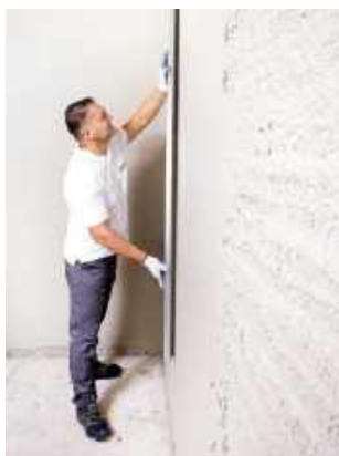
Tynk gipsowy umożliwia uzyskanie gładkiej powierzchni – odpowiedniej m.in. pod tapetę. DOLINA NIDY
