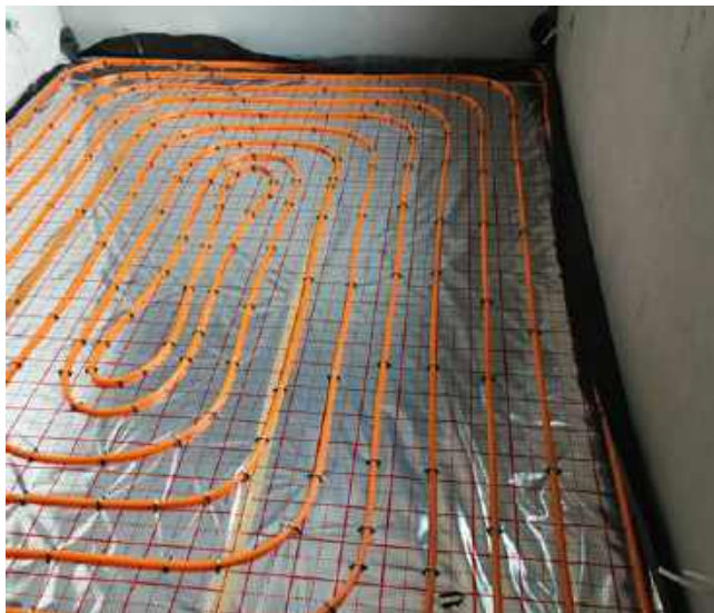
🔦 Rury grzewcze tworzą pętle, których długość nie przekracza z reguły 100 m. RWC
