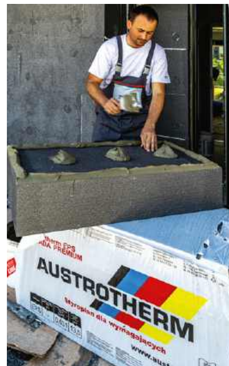
b W metodzie lekkiej mokrej zaprawę klejową nanosi się na płyty metodą obwodowo-punktową. AUSTROTHERM
