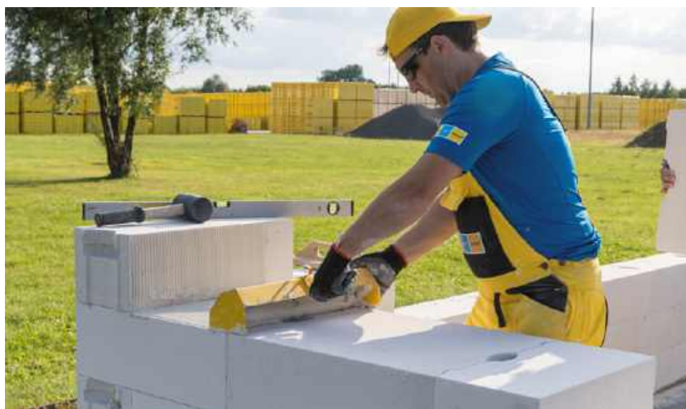
Ściany jednowarstwowe nie mają ocieplenia, które jest szczególnie narażone na uszkodzenia. Wybór takiej technologii redukuje prace o wykonanie ocieplenia oraz warstwy zbrojonej. YTONG (XELLA)
