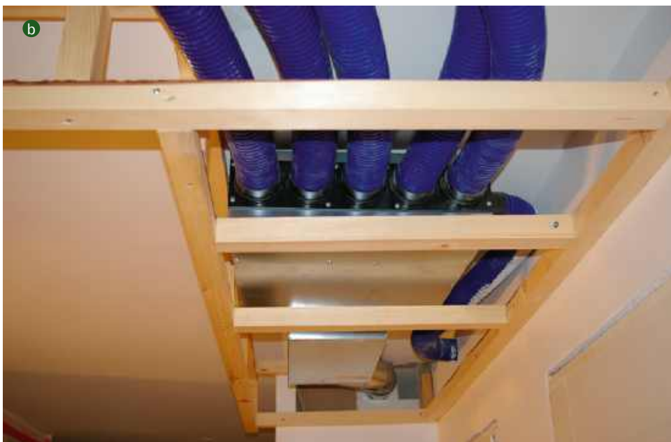
📍 Kanały wentylacyjne można ukryć pod wylewką podłogową (a WOLF), albo prowadzić nad sufitem podwieszanym (b CONCEPT AIR).
