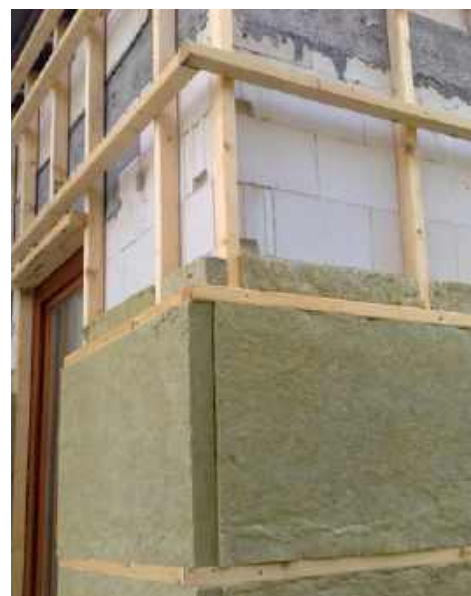
W metodzie lekkiej suchej ocieplenie podtrzymuje ruszt z drewnianych listew lub metalu. ARCHIWUM BD
