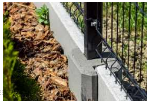
☑ Prefabrykowane podmurówki to gotowe elementy – deski i łączniki betonowe. Ich zastosowanie eliminuje konieczność wykonywania szalunków. JONIEC
