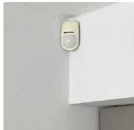
❗ Czujniki ruchu instaluje się na wysokości 2,10–2,40 m od posadzki z ukierunkowaniem na okna i drzwi. ARCHIWUM BD
