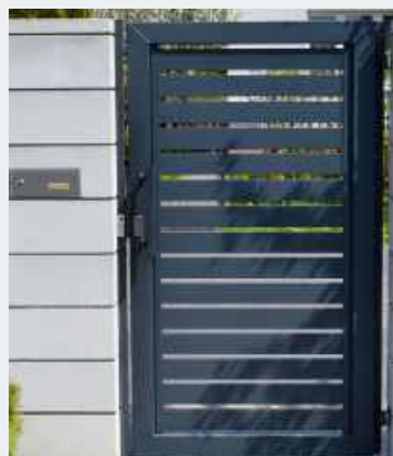
📌 W murek przy furtce (1 m) wbudowano skrzynkę na listy i wideodomofon.
