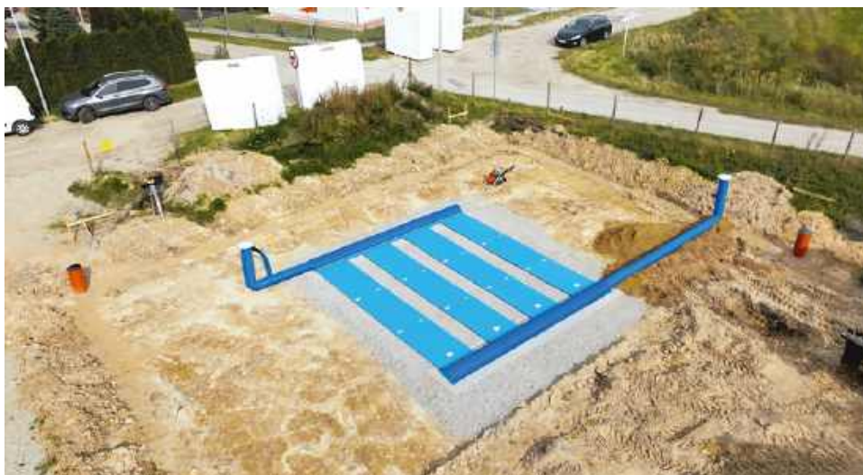
📍 Gruntowy wymiennik ciepła – wariant bezprzeponowy płytowy. PRO-VENT
