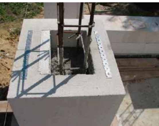
🔗 Wykonanie rdzenia żelbetowego w kształtkach U w ścianie jednowarstwowej. T. RYBARCZYK
