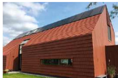
📍 Jednym z aktualnych trendów jest pokrycie dachowe, które płynnie przechodzi na elewację. WIENERBERGER
