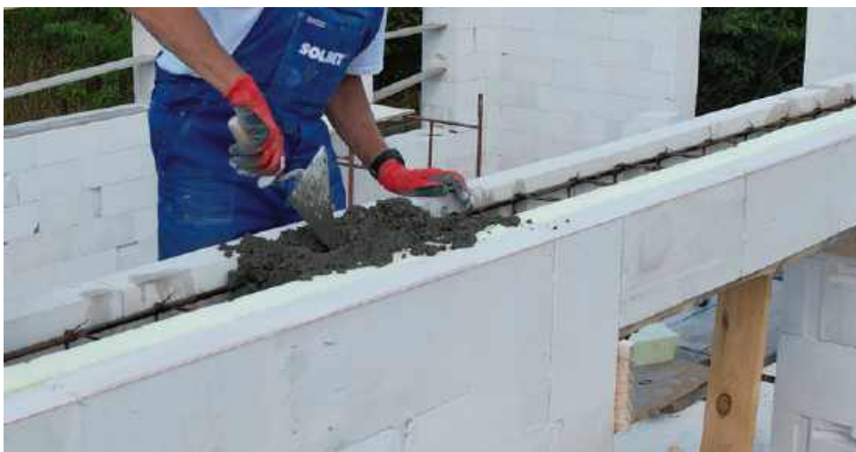
🔗 Wykonanie wieńca i nadproża z kształtek U w ścianie jednowarstwowej. T. RYBARCZYK
