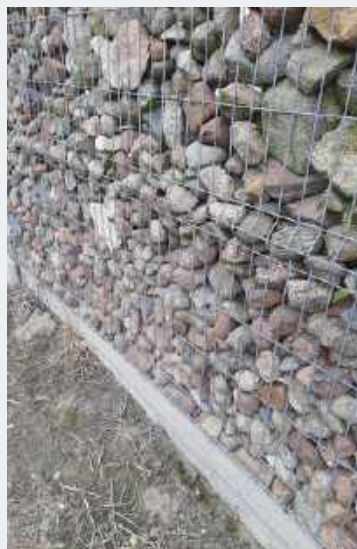
🔗 Wykorzystano też betonowe elementy podmurówki i słupki stalowe.
