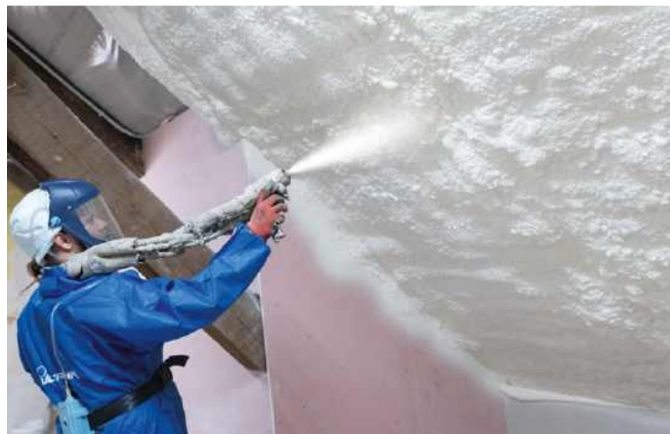
🔥 Piankę poliuretanową nakłada się na poddaszach metodą natryskową. Aby uzyskać wymaganą przepisami ciepłochronność, trzeba zastosować przynajmniej kilkunastocentymetrową warstwę. ULTRAPUR
