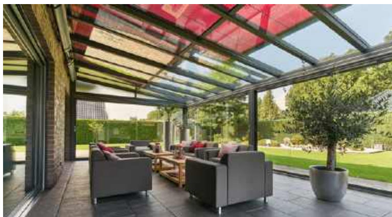
❗ Zadaszenie tarasu, wykonane z hartowanego szkła opartego na aluminiowej konstrukcji, i markizy. MARKILUX
