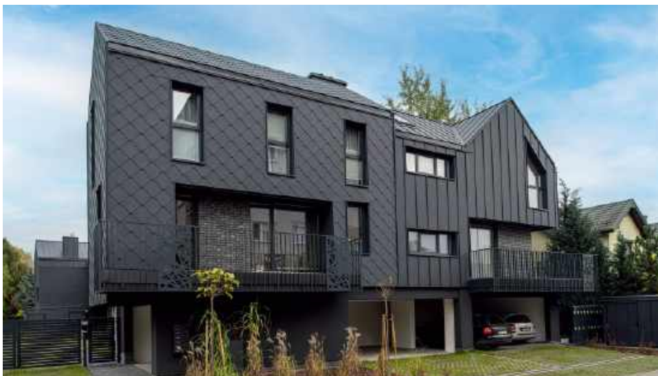
Blachę płaską można montować nie tylko na dachu, ale również na elewacjach. BLACHY PRUSZYŃSKI
