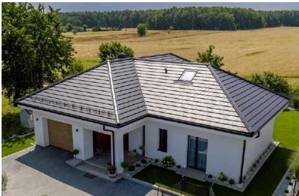
📍 Dach pokryty ceramiczną dachówką płaską o wymiarach 298 x 500 mm. Do pokrycia 1 m 2 połaci potrzeba 10,4 sztuk. SWISSPORTON
