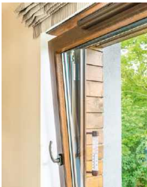
📍 W nowych, szczelnych domach niezbędnym elementem systemu wentylacji grawitacyjnej stały się nawiewniki, montowane w górnej części okna. KRISHOME
