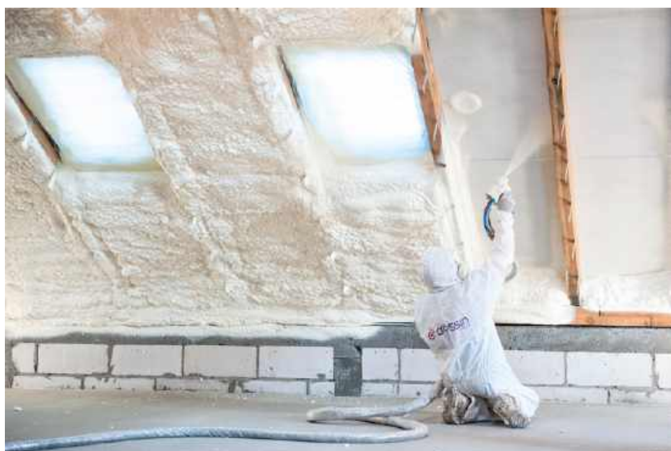
🔧 Poddasza coraz częściej ociepla się nanoszoną natryskowo pianą PUR. PCC PRODEX
