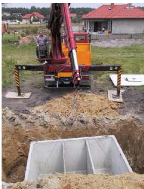
📍 Betonowy zbiornik szamba osadzany przy pomocy samochodowego dźwigu. PROBUD
