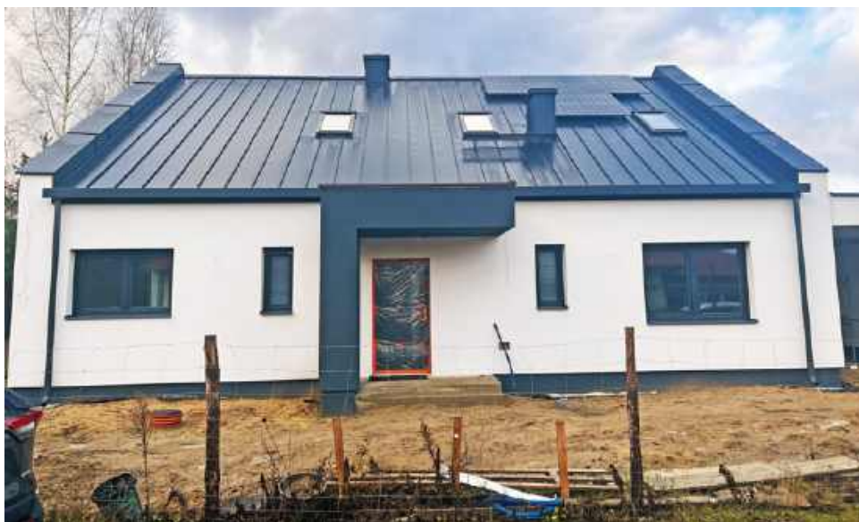
Standardowe wykończenie elewacji budynku z ociepleniem za pomocą tynku cienkowarstwowego. T. RYBARCZYK
