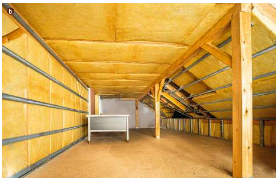
a Najpopularniejsze rozwiązania w ociepleniach – styropian na ściany ( a ARBET) i wełna mineralna na poddaszu ( b ISOVER).
