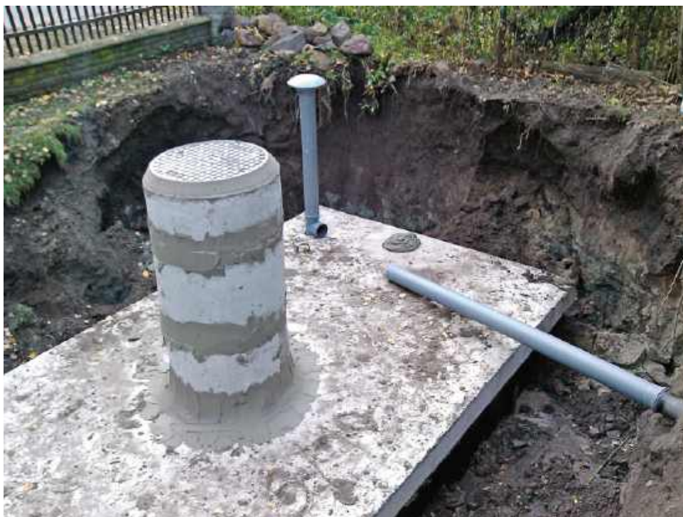
Na działkach bez dostępu do kanalizacji ścieki przeważnie odprowadzane są do szamb. ECOBET
