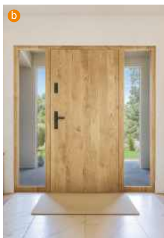
📌 Pojedyncze skrzydło drzwi wejściowych ma szerokość przynajmniej 90 cm i wysokość 200 cm (a HÖRMANN). Przeszklenia boczne mogą mieć dowolną szerokość (b STALPRODUKT-ZAMOŚĆ).
