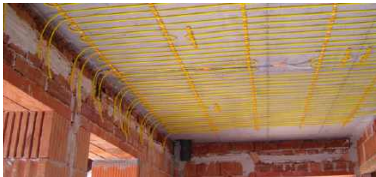
❗ Ogrzewanie płaszczyznowe w wersji sufitowej. HADWAO
