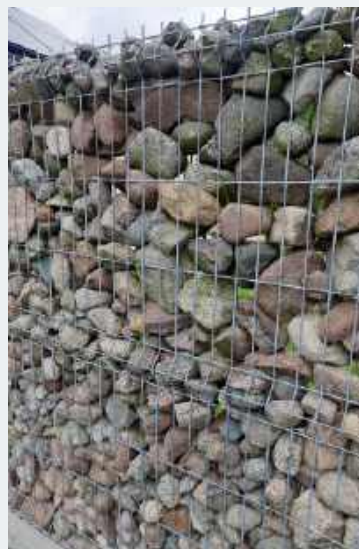
🔗 Ocynkowane prefabrykowane przęsła z drutu imitują gabiony.
