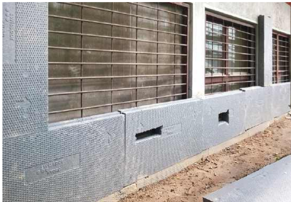
Do izolacji fundamentów stosuje się styropian o obniżonej chłonności wody. swisspor
