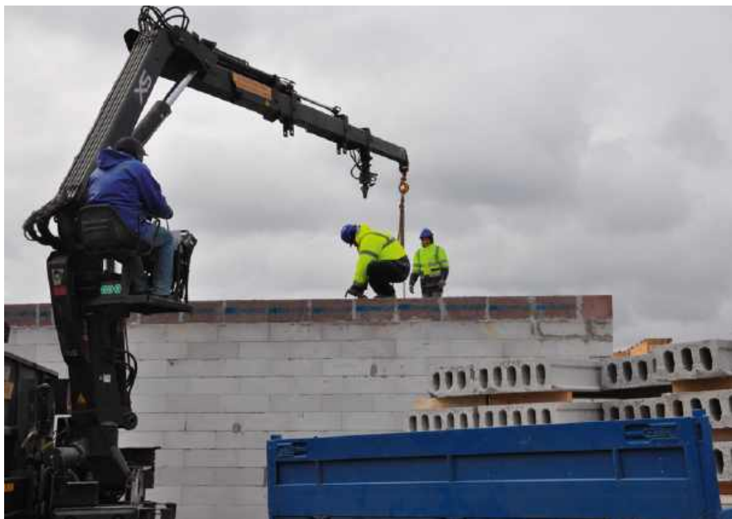
Do wykonania stropu panelowego nie jest potrzebny ciężki sprzęt – wystarczy samochód wyposażony w lekki dźwig typu HDS. STROPY.PL
