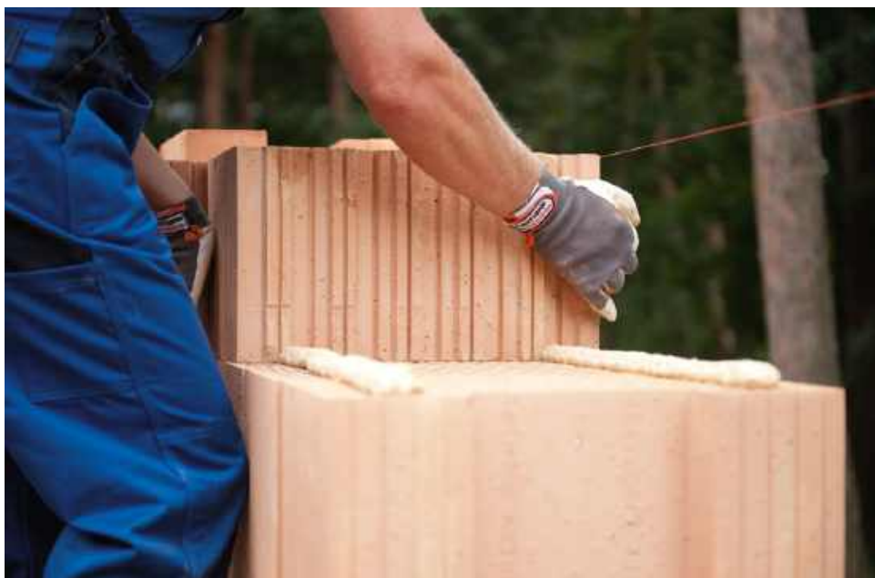
🔔 Bloczki z ceramiki poryzowanej bardzo dobrze chronią przed ucieczką ciepła, a przy tym nie są ciężkie, co ułatwia murowanie. WIENERBERGER
