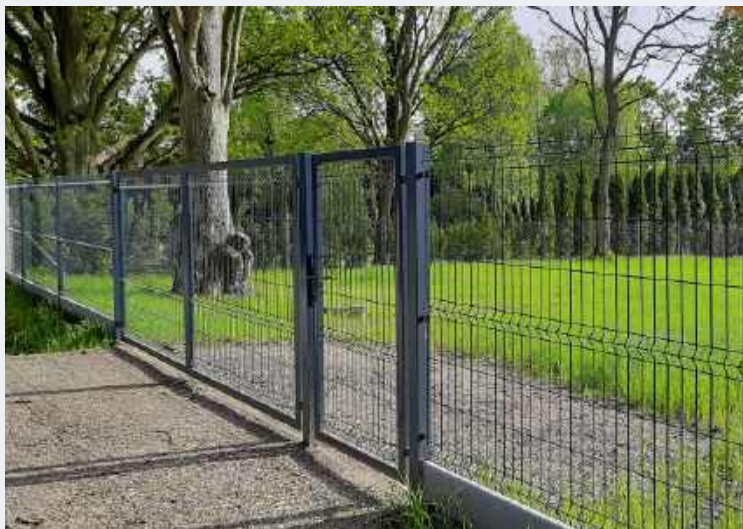
Graniczna bariera to prefabrykowane elementy z betonu i stali.
