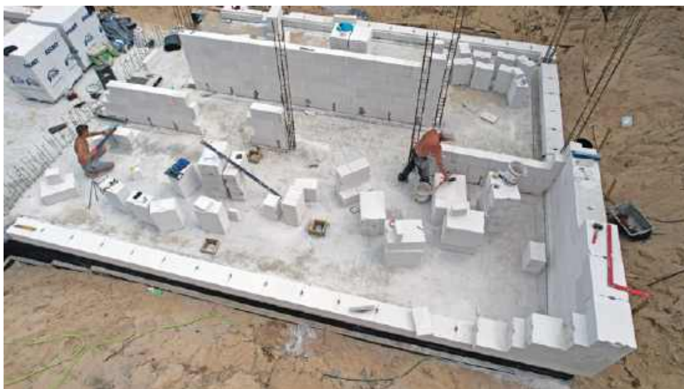
🔑 Beton komórkowy ma bardzo dobre parametry cieplne ze względu na powietrze zawarte w milionach porów. SOLBET
