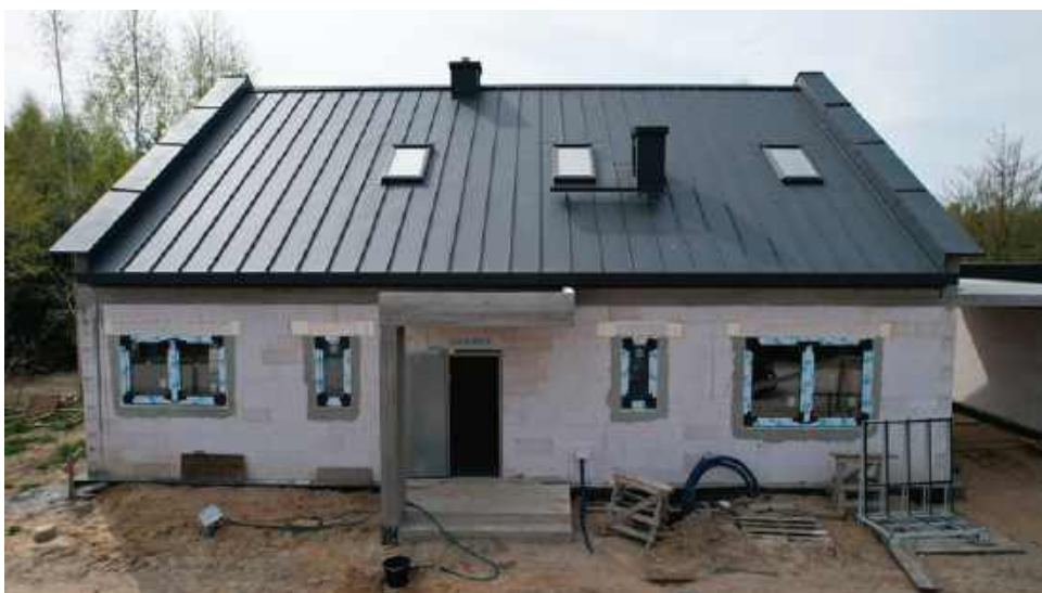
❷ Ściany zewnętrzne przed ociepleniem. T. RYBARCZYK
