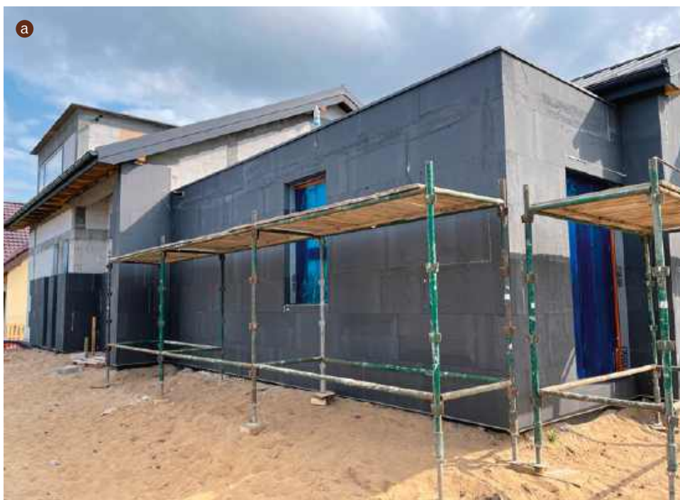
a Najpopularniejsze rozwiązania w ociepleniach – styropian na ściany ( a ARBET) i wełna mineralna na poddaszu ( b ISOVER).
