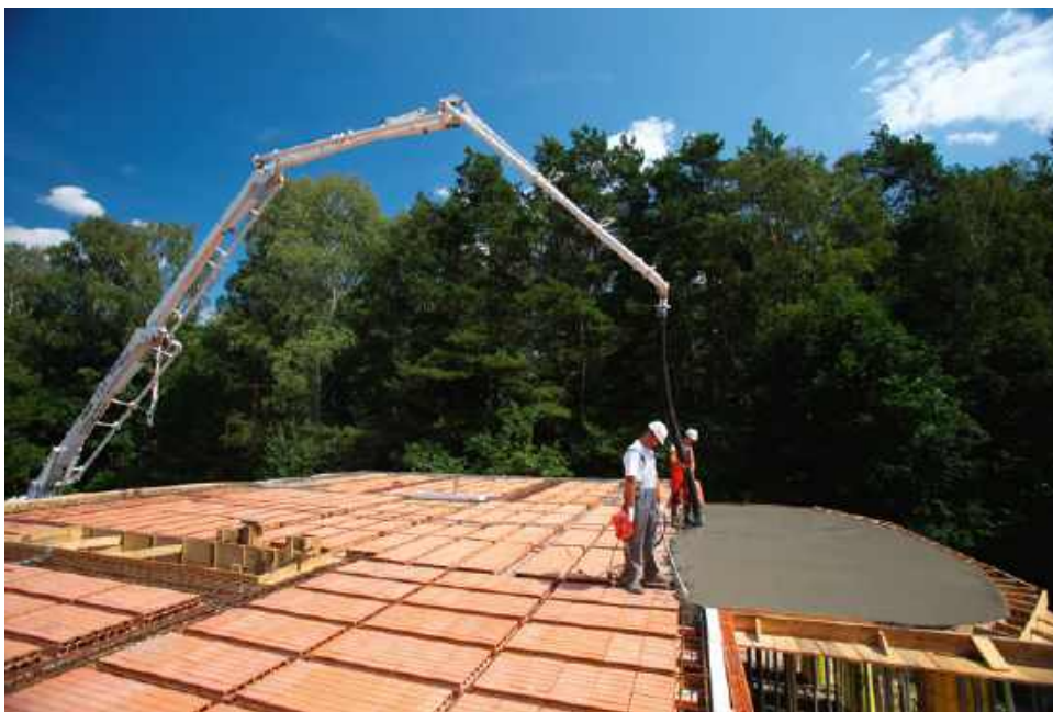
Koszt wykonania stropu kalkulowany jest indywidualnie – zależy m.in. od rozpiętości, kształtu konstrukcji, a także robocizny czy odległość inwestycji od fabryki produkującej jego elementy. WIENERBERGER
