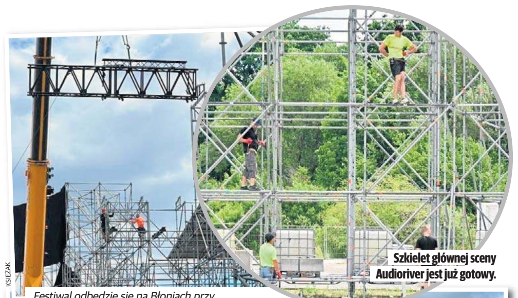
Festiwal odbędzie się na Błoniach przy ul. Konstanyńowskiej 96 (w rejonie skrzyżowania z ul. Juszcakiewicza). Od kilku dni trwa tam budowa wielkich scen.
