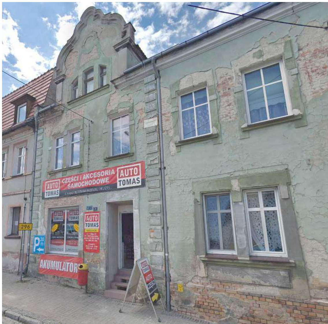
Kamienica nr 20 przy ul. 1 Maja otrzymała aż 120 tys. zł. W ramach prac zostanie zrobiona m.in. elewacja
