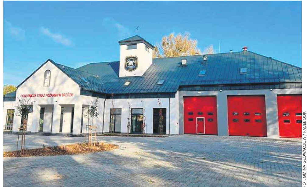
W Brzózcie otwarto nową strażnicę Ochotniczej Straży Pożarnej wraz ze świetlicą wiejską. Będzie miejscem integracji mieszkańców.
