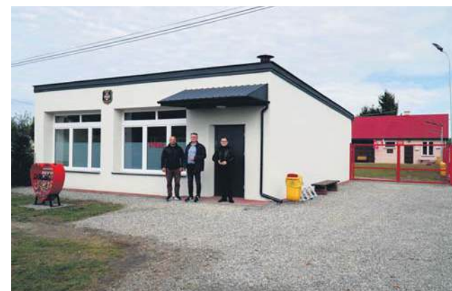
Zmodernizowana strażnica OSP w Zamościu Starym
