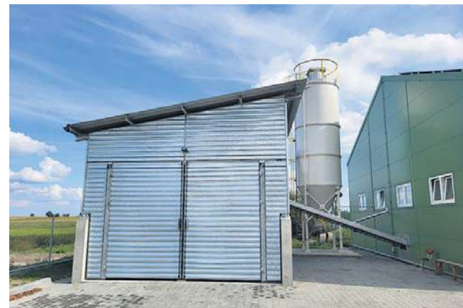
Nowo wybudowana wiata na osad po higienizacji oraz silos
