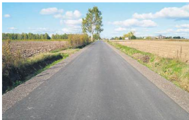
Przebudowana droga w Przyłęku
