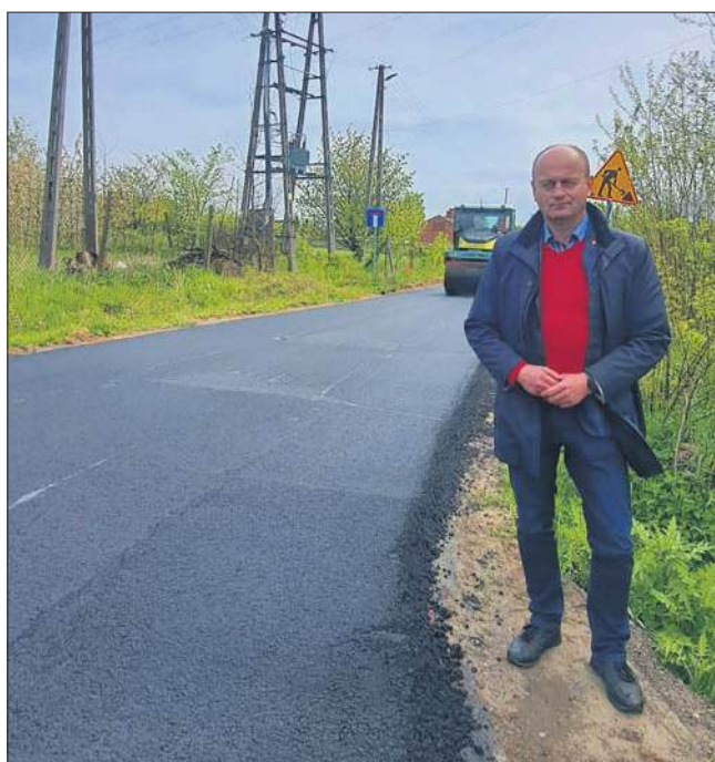
Przebudowa drogi w Kruszewie
