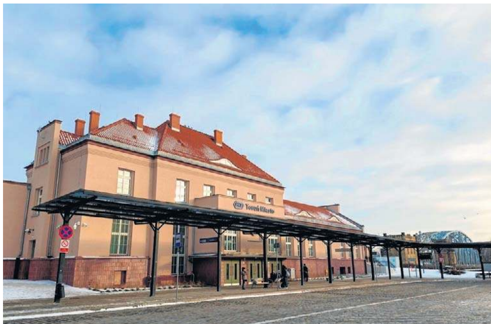
Tak wygląda Dworzec Toruń Miasto oddany niedawno do użytku podróżnym po długim remoncie
