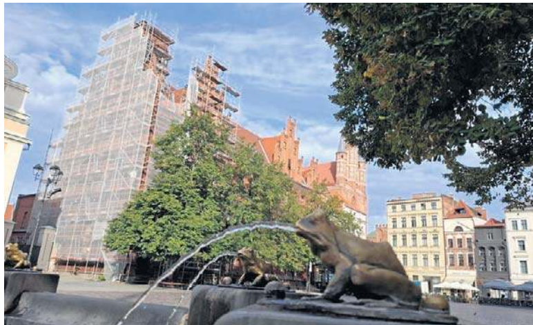
Gmach toruńskiej Poczty Głównej jest w remoncie. Poczta Polska, nadal szuka najemców na pomieszczenia na starówce
