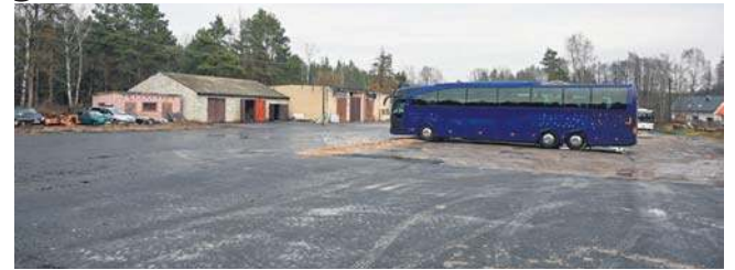
Na terenie Powiatowego Zarządu Dróg Publicznych w Białobrzegach wykonano nową nawierzchnię placu.
