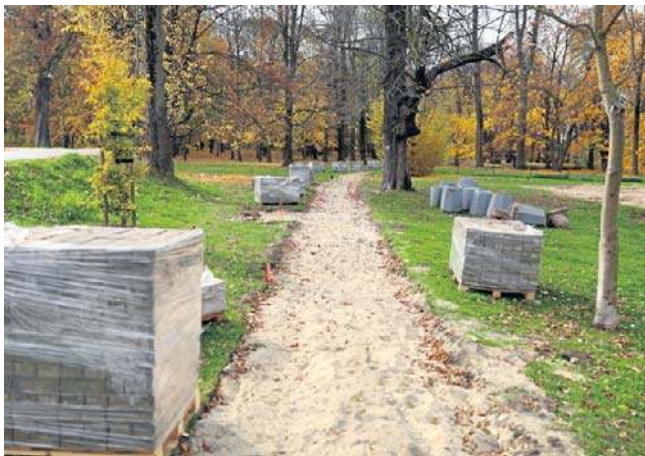
Po zdemontowaniu kilka tygodni temu starego chodnika, prace przy budowie nowego jeszcze się nie zaczęły
