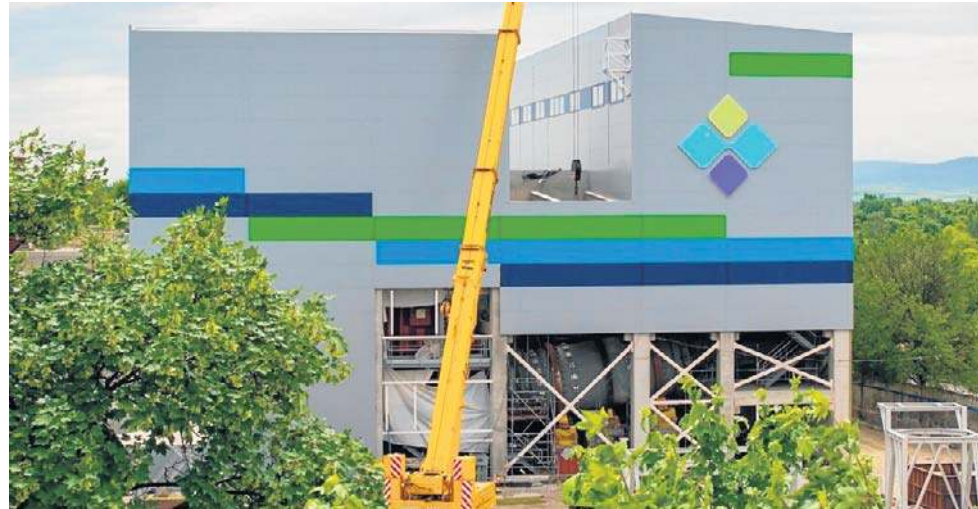
Na obecnym etapie zaawansowanie budowy spalarni odpadów w Krośnie przekracza 60 procent. Według założeń ma spalać rocznie ponad 20 tysięcy ton odpadów
