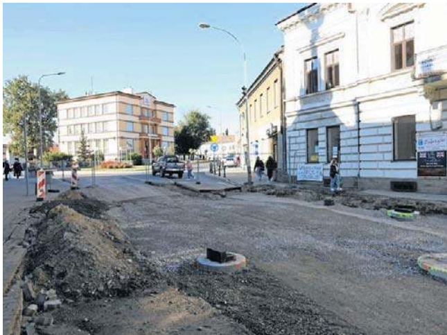
Fragment przebudowywanego placu Mickiewicza w Jarosławiu
