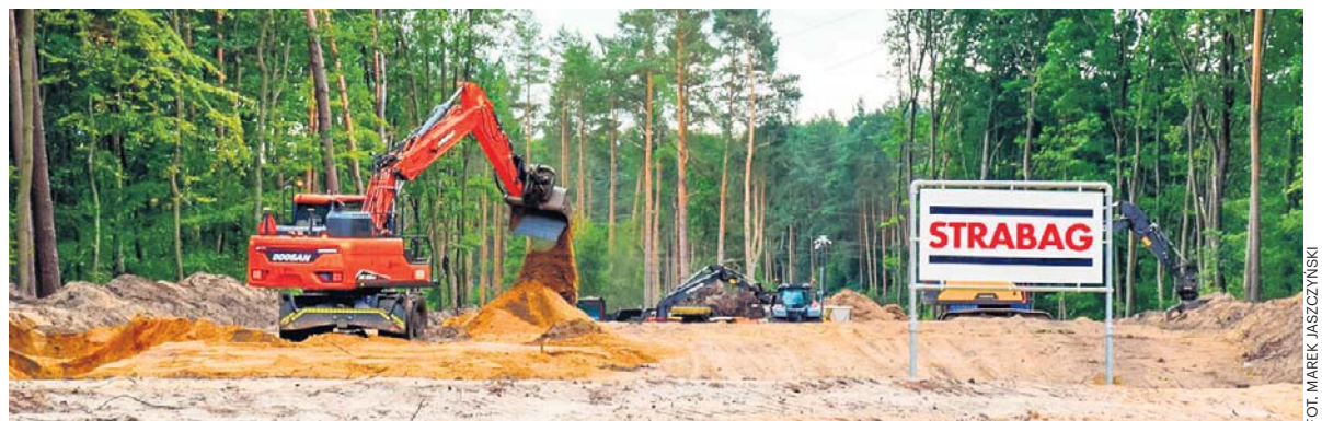
Zgodnie z kontraktem odcinek od ul. Tanowskiej w Policach do ul. Szczecińskiej w Przęsocinie ma być gotowy w listopadzie 2028 roku
