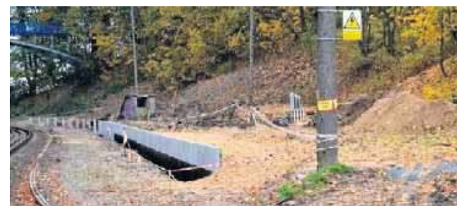
PLK chcą, by prace przy SKM do końca 2023 r. były skończone
