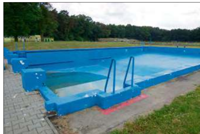
Niecki są w trakcie remontu.
