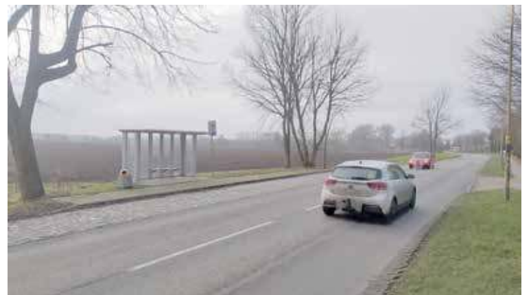
Z przystanku nie ma poprowadzonego oznakowania przejścia dla pieszych
