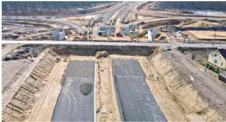
Prace w terenie rozpoczęły się w grudniu 2024 r., niedługo po wydaniu przez wojewodę lubelskiego decyzji o zezwoleniu na realizację inwestycji drogowej
