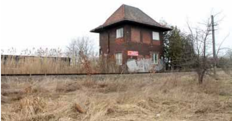
Przystanek na Os. Pyrzyckim od lat "straszy" przejezdnych i przechodniów. A przecież mógłby stanowić jeszcze jeden miejski element SKM
