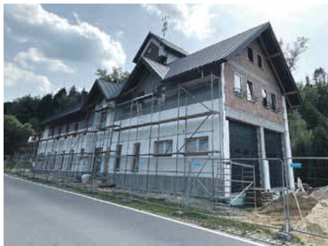
Budowa będzie kosztować ponad 2 miliony złotych.
