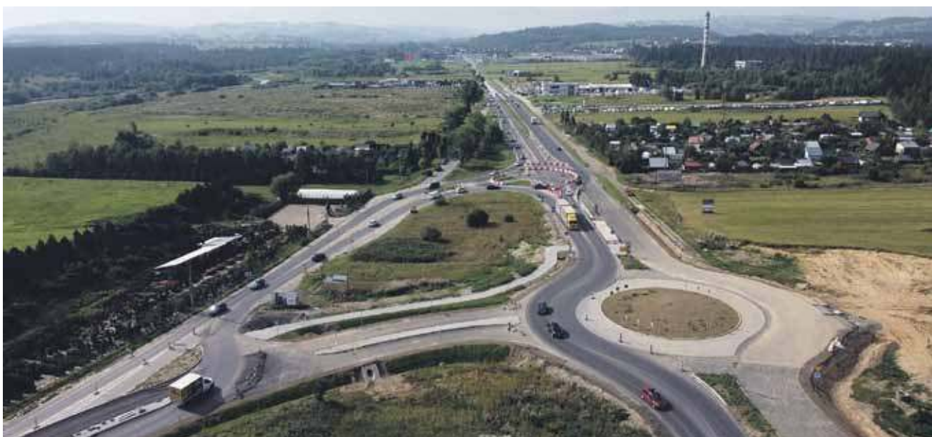
Nowe rondo u wylotu ul. Szaflarskiej w Nowym Targu jest już blisko ukończenia.
