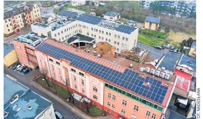
Moc tych modułów fotowoltaicznych wynosi 132 kilowatopików. To naprawdę wysoka moc instalacji
