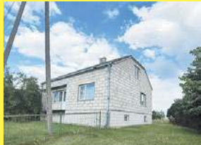
Dom w miejscowości Kościół przy ulicy Sławatyczej, 604 494 489
