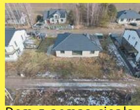
Dom z pompą ciepła i fotowoltaiką - Porosiuki, 604 494 489
