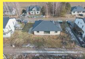
Dom z pompą ciepła i fotowoltaiką - Porosiuki, 604 494 489
