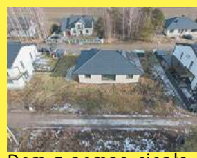
Dom z pompą ciepła i fotowoltaiką - Porosiuki, 604 494 489
