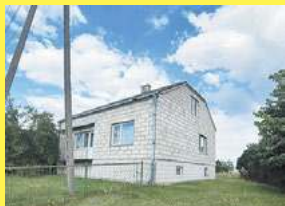
Dom w miejscowości Kościół przy ulicy Sławatyczej, 604 494 489
