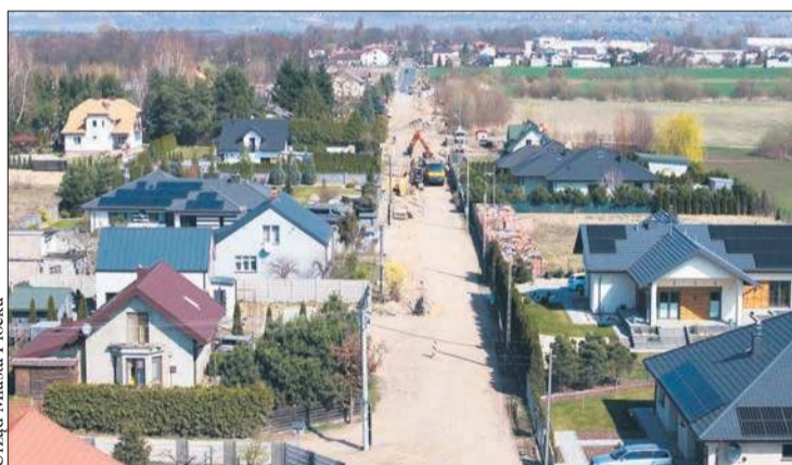
Trwa przebudowa ulicy Browarnej
