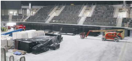
Hala Urania podczas przebudowy
