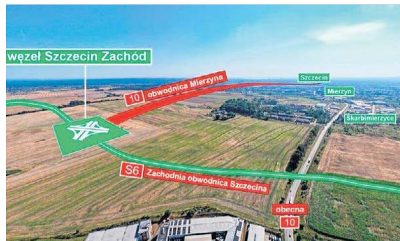
Szczegóły budowy wykonawca drogi chce przedstawić na spotkaniu z mieszkańcami i samorządowcami
