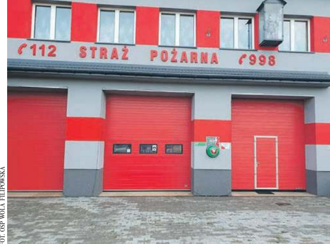
Urządzenie do ratowania życia umieszczone jest przy bramie wjazdowej do remizy
