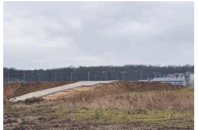
Miejsce, w którym ma być wykonany odwiert
