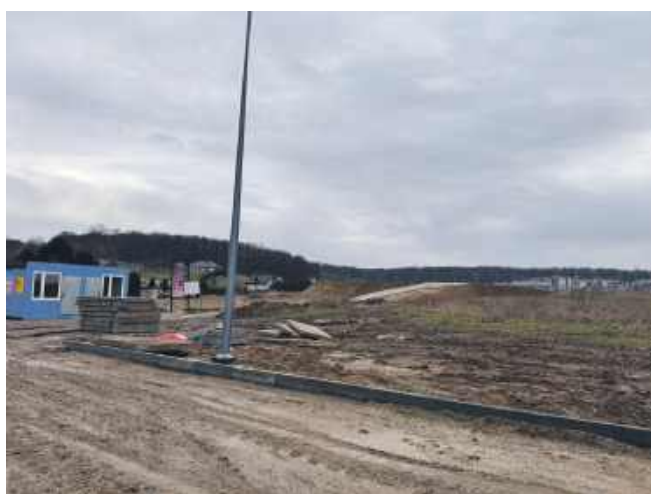
Tak wygląda plac budowy...
