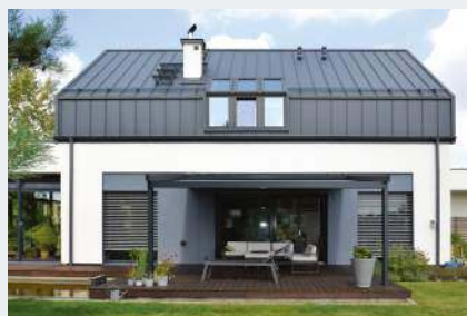
❸ Komin z systemowych kształtek wyprowadzono przez dach.
