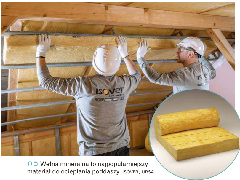
➡ Ocieplenie układa się w dwóch prostokątnych warstwach tak, aby łączenia płyt się nie pokrywały. ARCHIWUM BD
