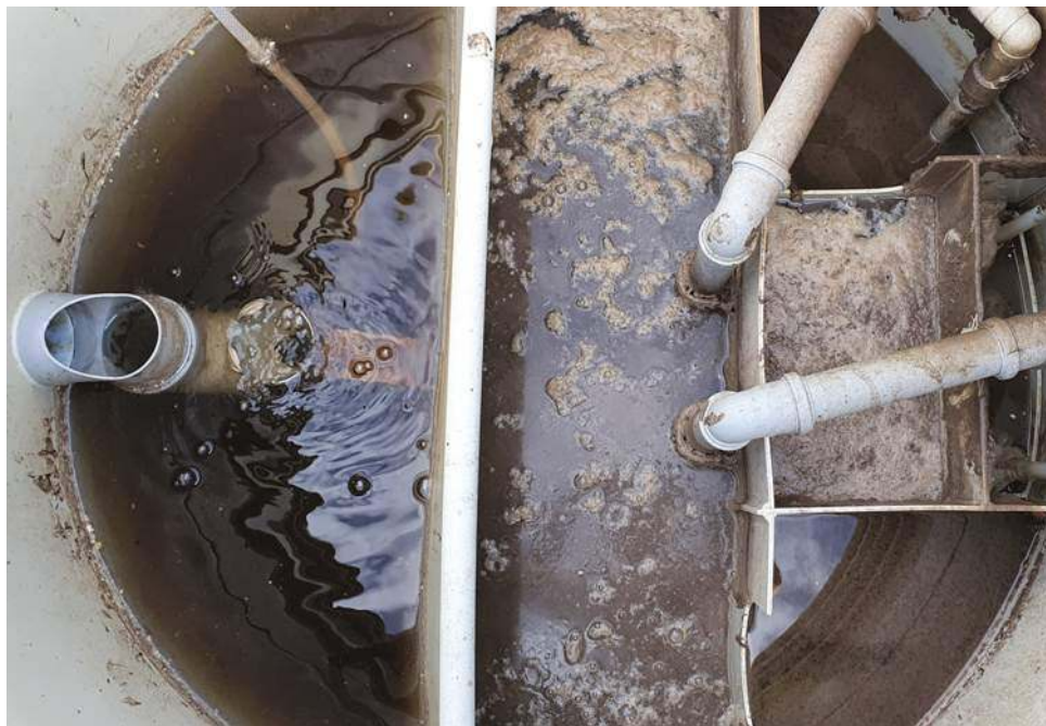
W przypadku oczyszczalni kompaktowej warunki gruntowe na działce nie mają znaczenia, bo oczyszczanie ścieków odbywa się w szczelnym zbiorniku. EKO HOUSE
