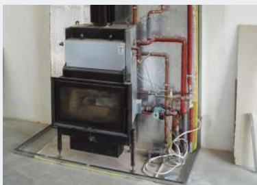
❷ Wkład kominkowy z płaszczem wodnym o mocy 8–19 kW i osprzęt.
