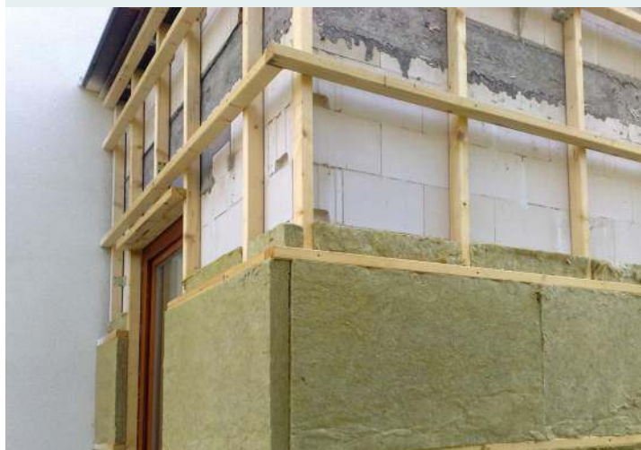
➡ Ocieplenie układa się w dwóch prostokątnych warstwach tak, aby łączenia płyt się nie pokrywały. ARCHIWUM BD
