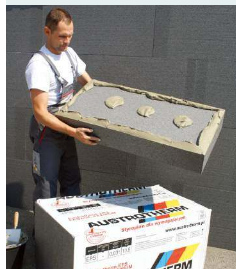
Zaprawę klejową nanosi się na płyty (nie na ścianę!), metodą obwodowo-punktową. AUSTROTHERM
