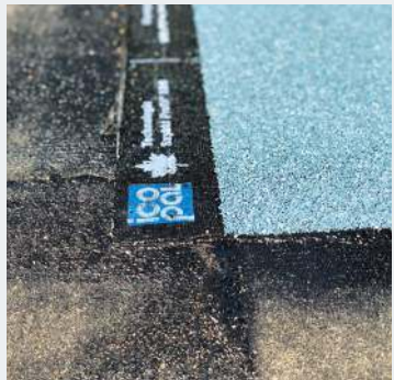
🔧 Na samoprzylepnej papie podkładowej ułożono papę wierzchniego krycia.
