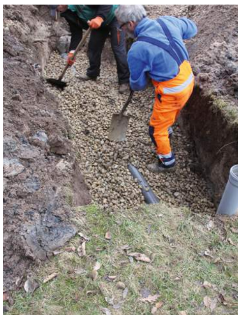
🔗 Oczyszczalnię z drenażem rozsączającym można wykonać tylko na posesji z przepuszczalnym gruntem. J. WERNER
