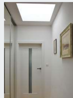
🔗 Oprócz kominów, w stropodachu zamontowano okno 90 x 90 cm.
