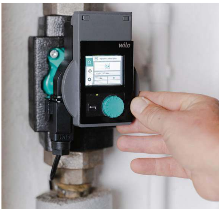
Nowoczesne pompy elektroniczne same dostosowują ciśnienie i przepływ do zmieniających się w instalacji c.o. warunków. WİLO
