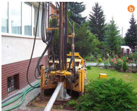
📍 Wykop pod poziomy kolektor gruntowy (a CLIMA KOMFORT) i odwiert pod wymiennik pionowy (b NIBE-BIAWAR).
