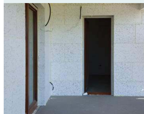
Połączenia płyt mają być przesunięte względem siebie. FOVEO TECH
