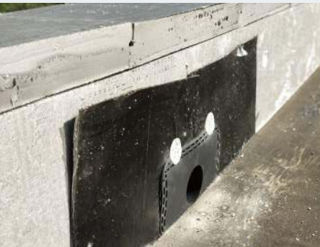
🔧 W wymurowanej attyce oprawiono 5 wpustów odpływowych.
