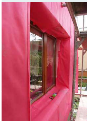
➡ Na wełnie mocuje się paro-przepuszczalną folię wiatrochronną, co zapobiega jej zawilgoceniu i pyleniu. ROCKWOOL
