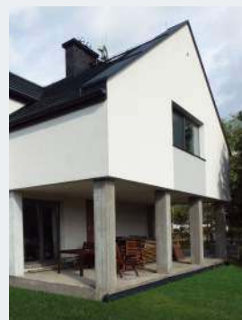
🔥 Komin z przewodem dymowym i stalowym „strażakiem” wzniesiono przy zewnętrznej ścianie (i przy tarasie).
