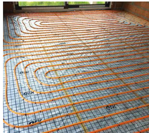
➡ Wodne ogrzewanie podłogowe zwykle wolno nagrzewa posadzkę, ale długo utrzymuje ona ciepło. RWC
