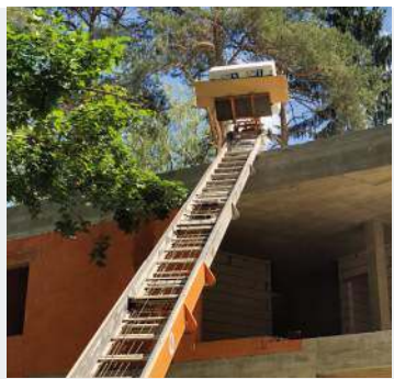
🔧 Ekipa dekarzy posługiwała się odpowiednim sprzętem, w tym windą-taśmociągiem.
