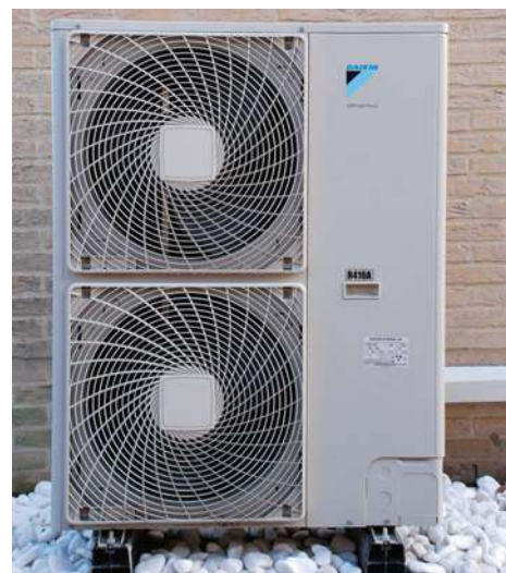
🔌 Jednostka zewnętrzna typu split. DAIKIN
