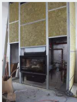
🔥 Wokół wkładu i osprzętu postawiono obszerną „zimną” obudowę.
