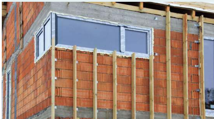
➡ Na początek z drewnianych listew lub metalu wykonuje się ruszt konstrukcyjny. J. WERNER
