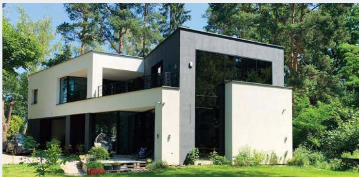
Nad bryłą piętrową wykonano niewentylowany dach z attyką i wykończono papą.
