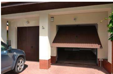
📌 Skrzydło w formie płyty uchylanej do góry, z przetłoczeniami w kształcie kasetonów.
