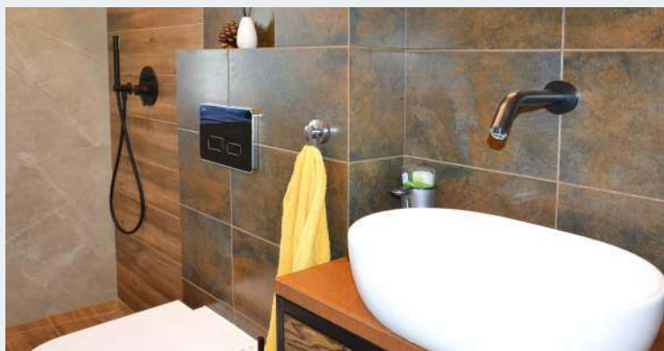
🔗 Na parterze, przy umywalce, zamontowano bezdotykową baterię z czujnikiem podczerwień.
