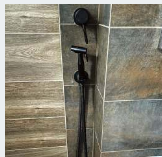
● Bidetkę ulokowano w wąskiej wnękce, przygotowanej w ścianie między sedesem a umywalką.
