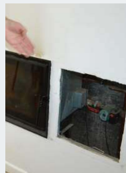
🔥 Jeden z trzech otworów rewizyjnych.
