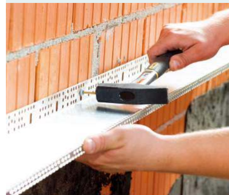
Na początku zakłada się listwę startową z aluminium lub ocynkowanej stali. BAUMIT
