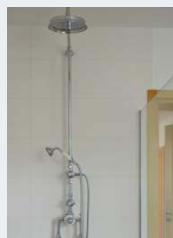
🔑 Pod natryskiem jest termostaatyczna wersja, z deszczownicą.
