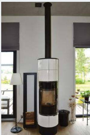
❶ Dorobiono obręcz pod piec, system spalin wyprowadzono od góry do komina (stoi na stropie nad parterem).
