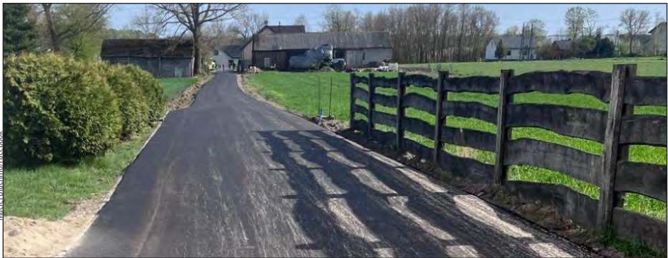
Prace rozpoczęły się od Ostrożenia Pierwszego
