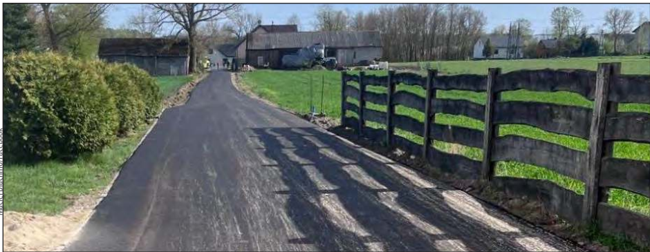
Prace rozpoczęły się od Ostrożenia Pierwszego
