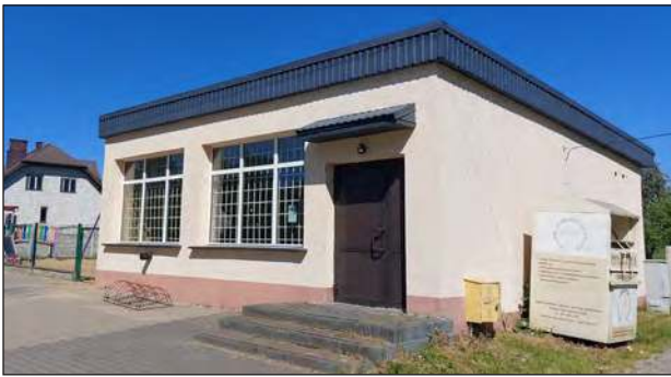
Budynek po byłym sklepie w Stodzewie od jesieni 2023 roku stoi pusty i zamknięty. Mieszkańcy, zaniepokojeni jego stanem, apelują o działanie, zanim popadnie w ruinę
