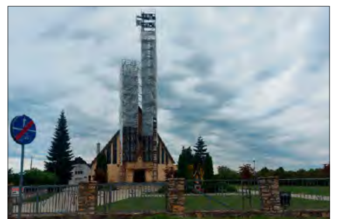
Wieża kościoła w Żywocicach podczas remontu.
