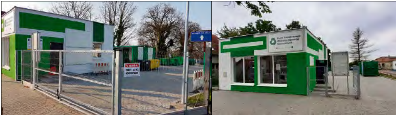
PSZOK w Krapkowicach umożliwia mieszkańcom odpowiedzialne przekazywanie odpadów, które wymagają selektywnego zagospodarowania.
