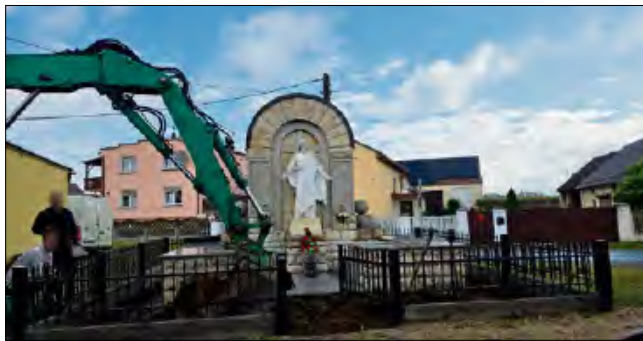
Dzięki tegorocznym pracom miejsce, które przypomina o mieszkańcach Grocholubia poległych podczas I wojny światowej, odzyskało bardziej godną oprawę.
